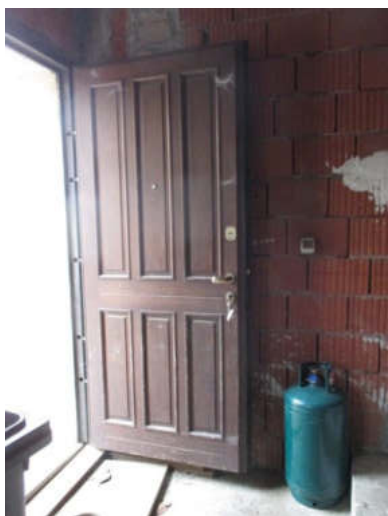
Unità 2 interno unità a rustico su due piani
