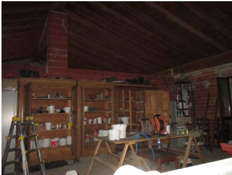
porzione al rustico primo piano
