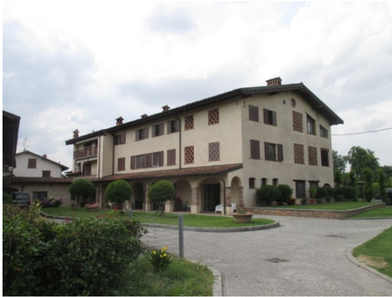
vista dal cortile
