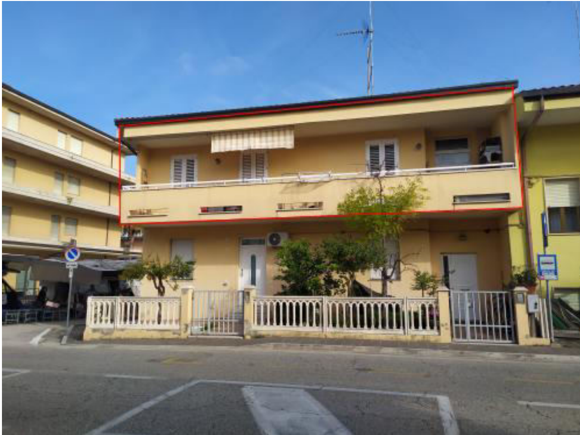
Foto 1 – Vista prospetto ovest da via Mazzini (S.S. 16)
