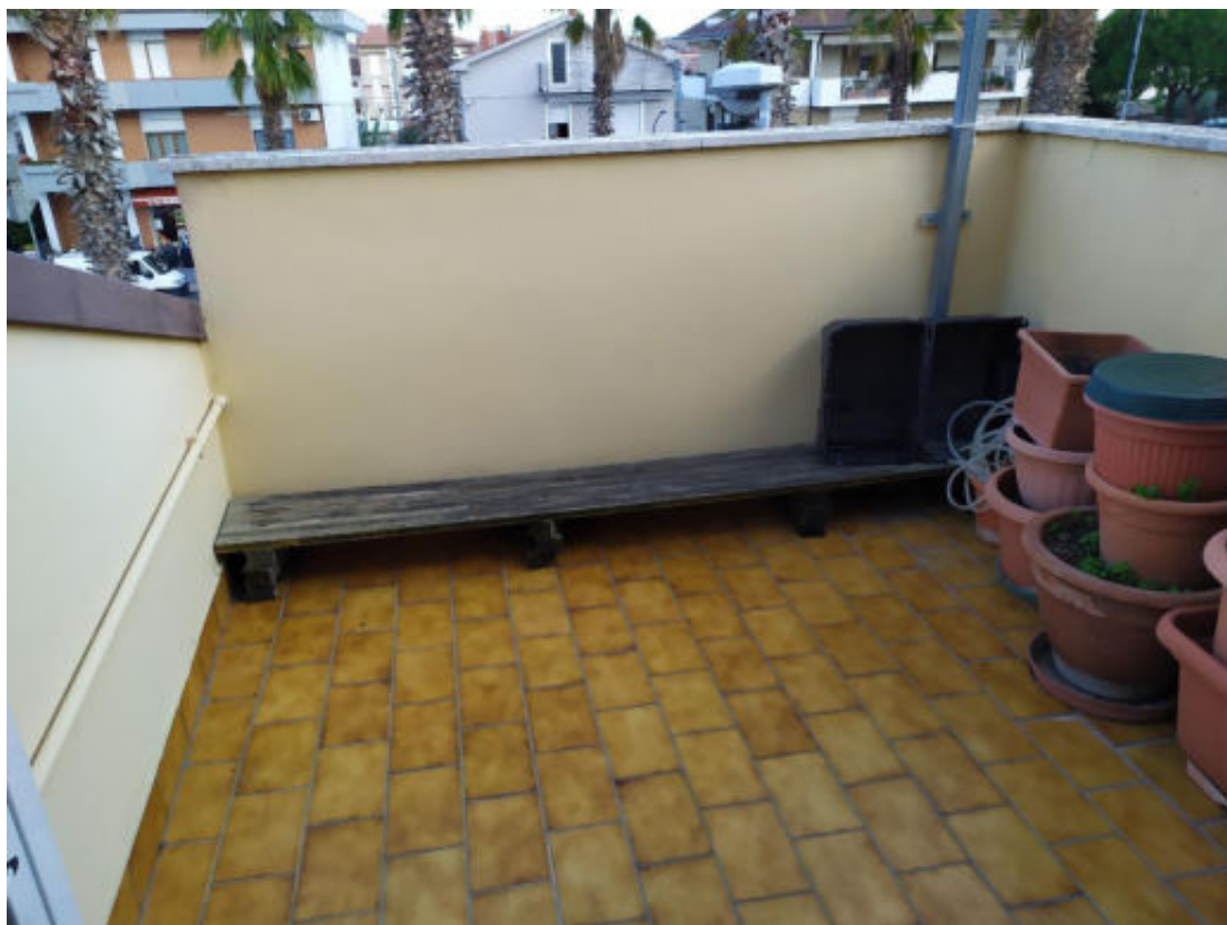
Foto 30 – Vista terrazzino del piano secondo
