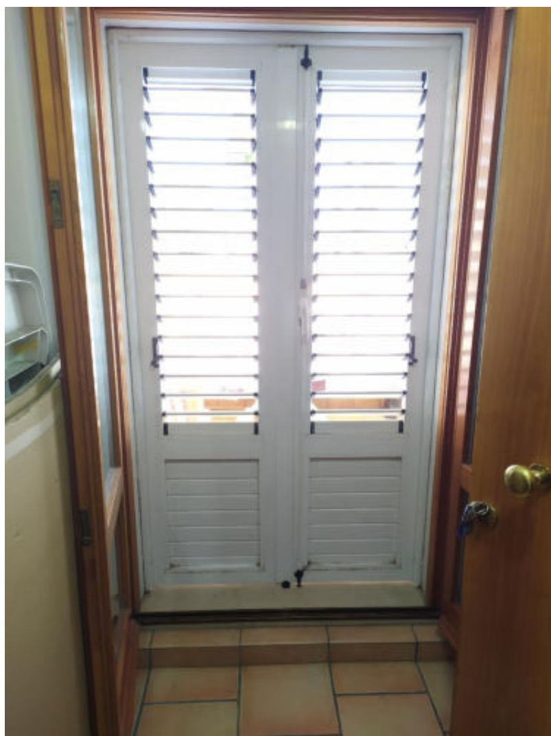
Foto 28 – Vista accesso al terrazzino visto dall'interno
