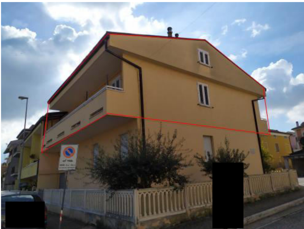
Foto 2 – Vista angolo nord ovest
