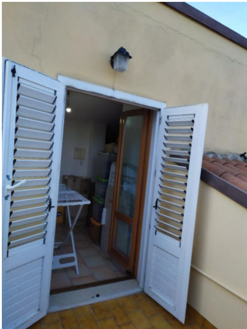
Foto 29 – Vista accesso al terrazzino dall'esterno
