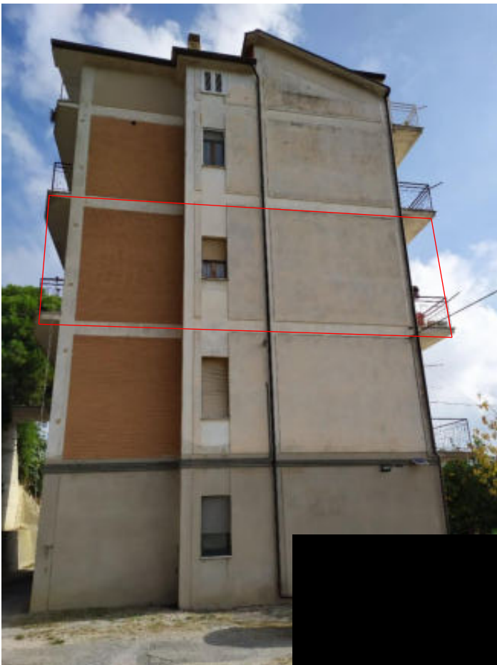
Foto 4 – Vista facciata ovest dell'edificio
