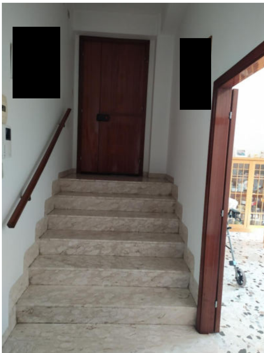
Foto 5 – Vista gradini ingresso dal corridoio
