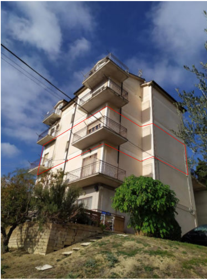
Foto 3 – Vista facciata sud ed est dell'edificio
