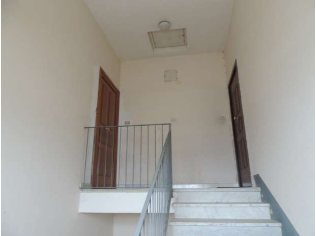
FOTO 1: Pianerottolo piano secondo (l'ingresso all'immobile staggito è quello a destra)
