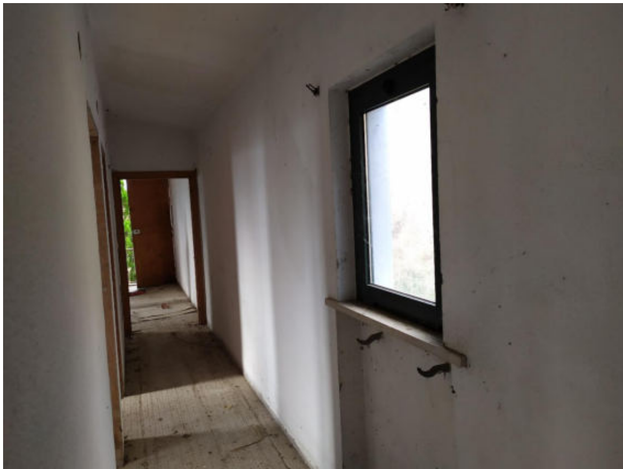
Foto 11 – Corridoio verso l'ingresso
