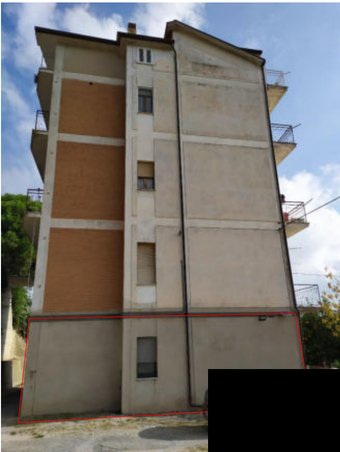
Foto 4 – Vista facciata ovest dell'edificio
