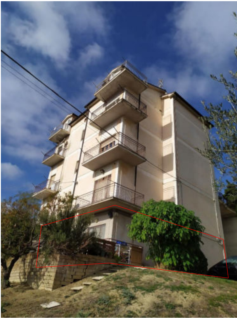
Foto 3 – Vista facciata sud ed est dell'edificio
