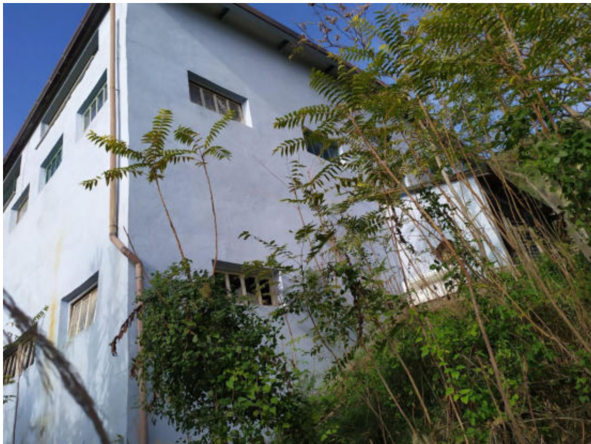
Foto 7 – Vista facciata est capannone dalla rampa sul seminterrato
