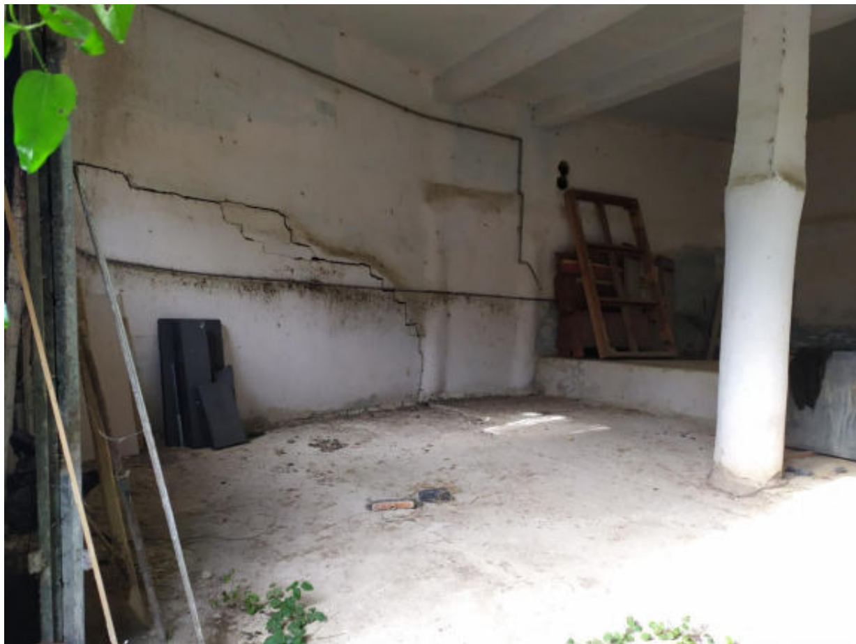
Foto 17 – Capannone - Vista interno verso lato ovest del piano seminterrato
