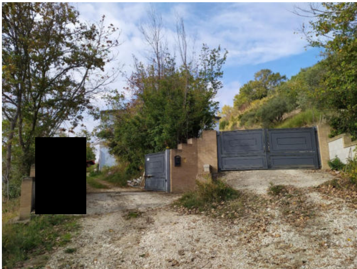
Foto 1 – Vista ingresso ai lotti 2 e 3 da strada provinciale Montonese
