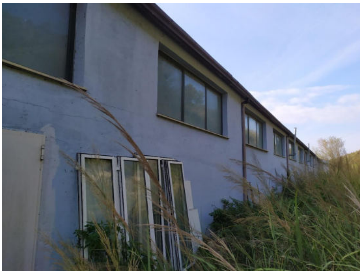
Foto 8 – Vista facciata nord capannone
