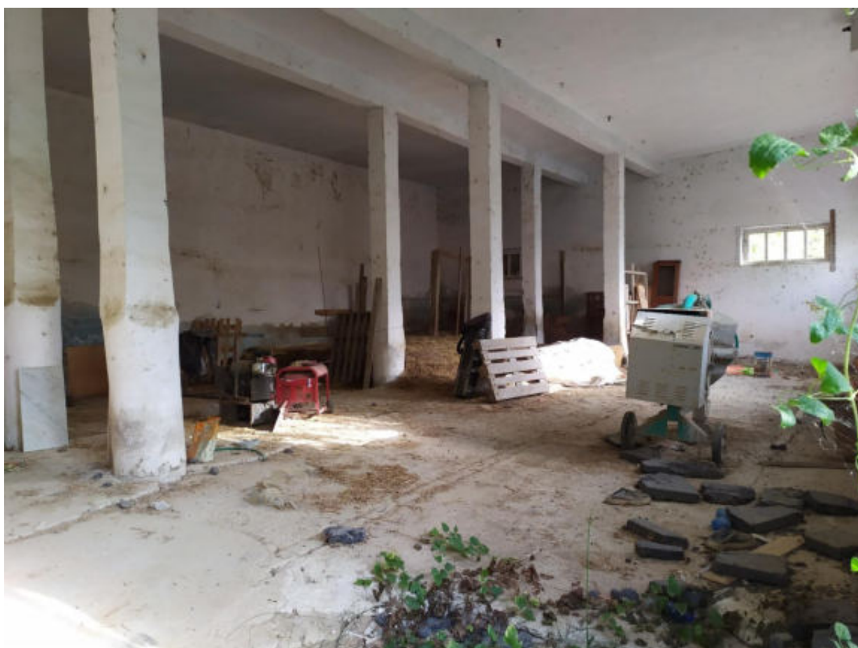
Foto 16 – Capannone - Vista interno verso lato est del piano seminterrato
