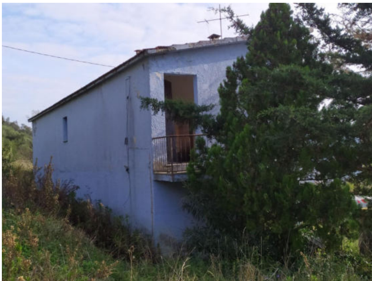
Foto 10 – Vista angolo nord ovest edificio uffici al PT (abitazione al P1 lotto n° 3)
