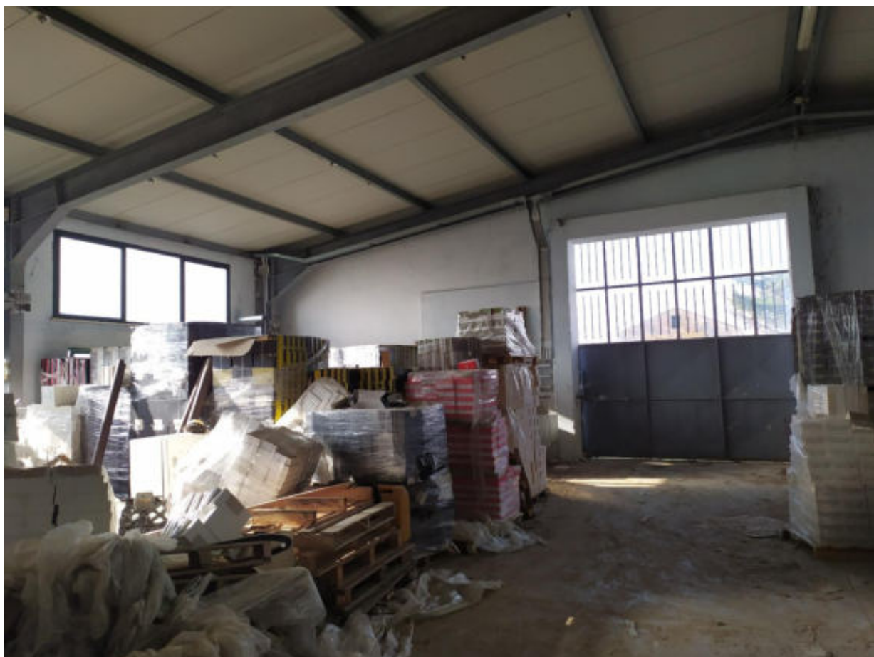
Foto 15 – Capannone - Vista ingresso principale dall'interno
