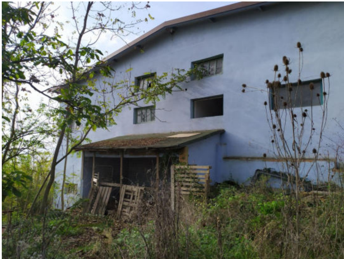
Foto 6 – Vista facciata est del capannone
