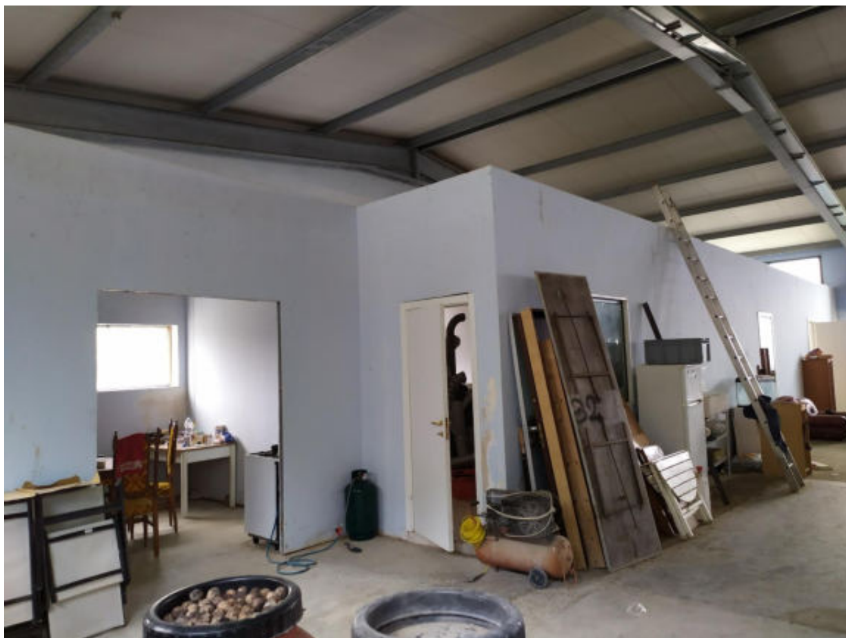
Foto 13 – Capannone - Vista interno lato est – particolare dei locali foresteria
