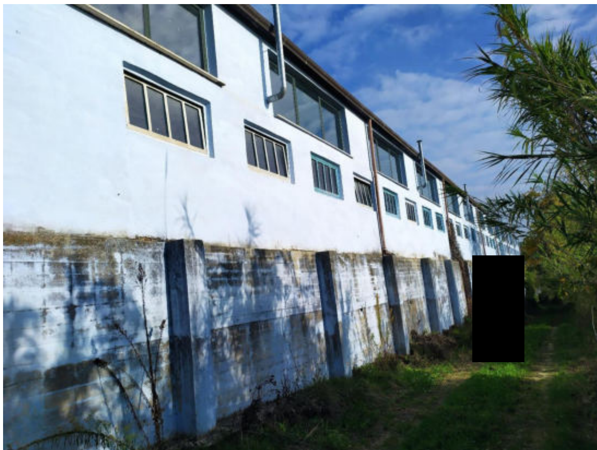
Foto 5 Vista stessa facciata e rampa da lato opposto di foto 4
