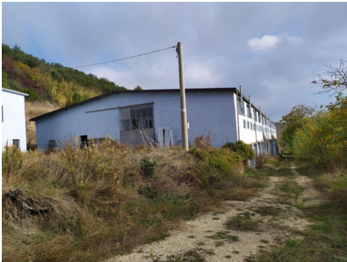
Foto 3 – Vista angolo sud ovest capannone con rampa d’accesso al piazzale
