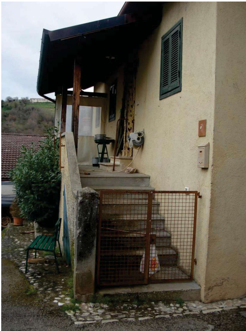
FOTO n. 5 – rampa di accesso a piano primo dalla pubblica via.
