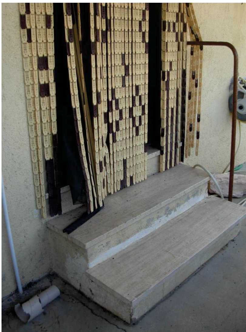
FOTO n. 10 – gradini antistanti la porta di ingresso all'appartamento a primo piano.
