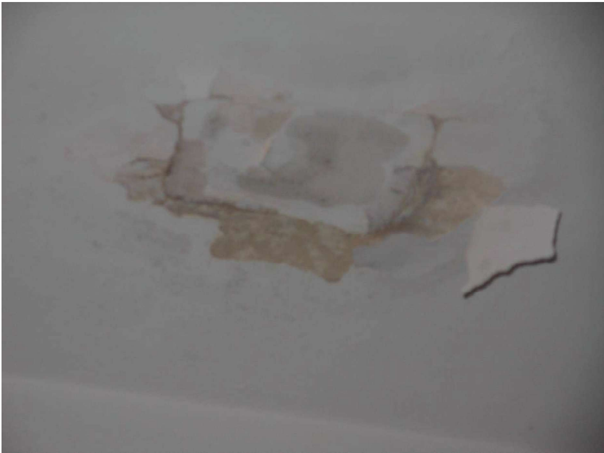
FOTO n. 20 – idem foto n. 19
