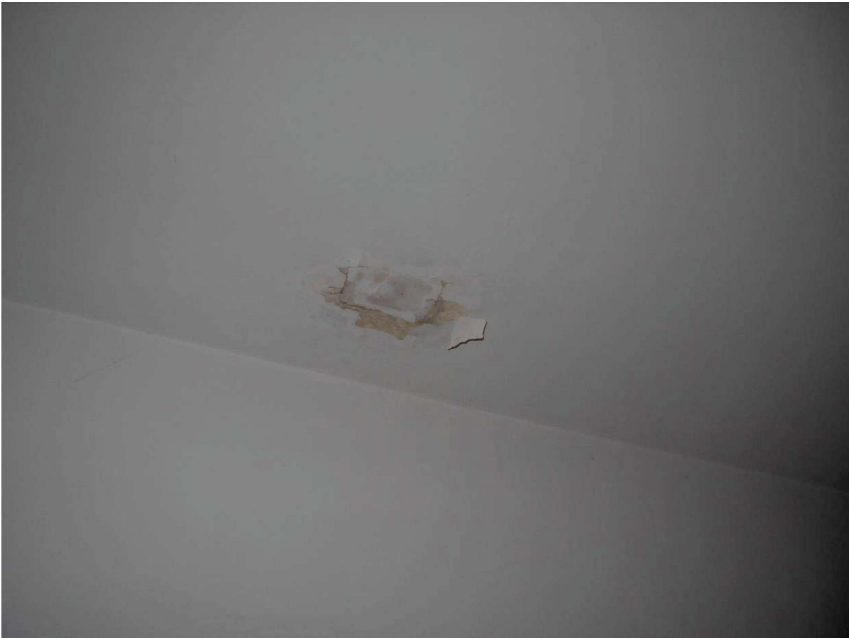
FOTO n. 19 – infiltrazione soffitto camera maggiore
