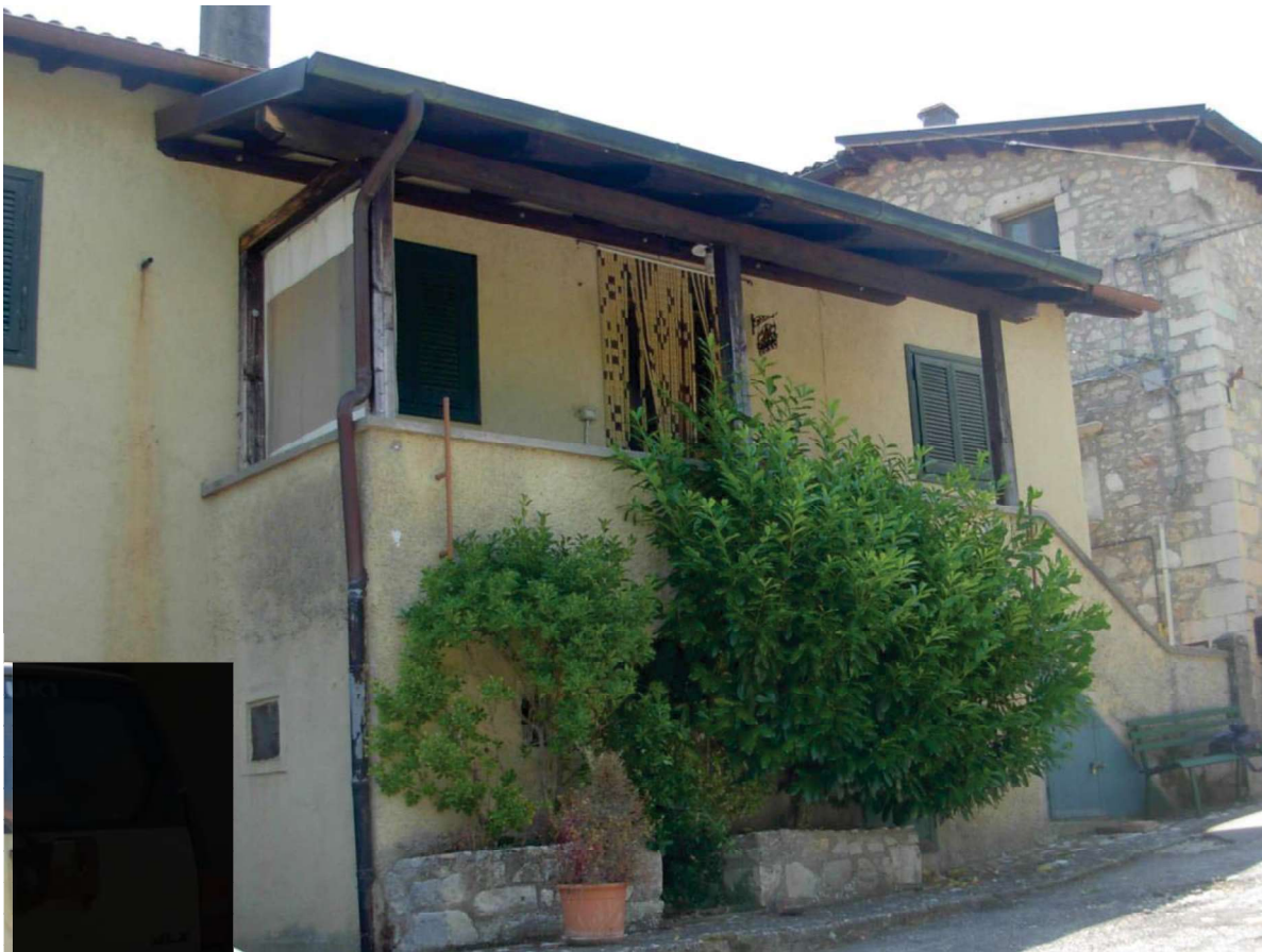
FOTO n. 11 – tettoia lignea a copertura del pianerottolo a piano primo (terrazzo).
