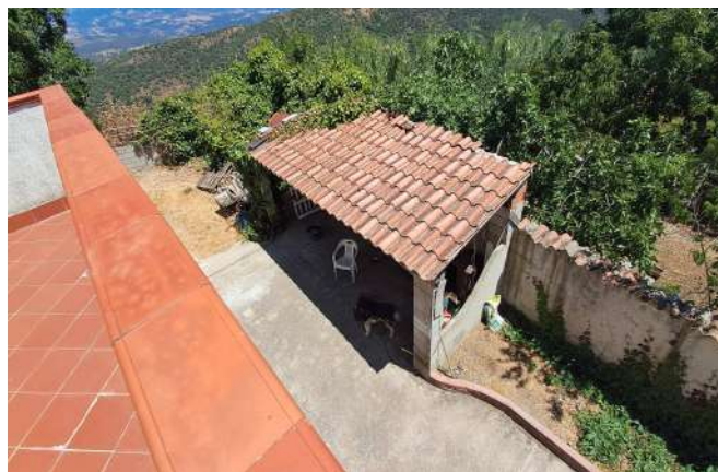
8. Tettoia vista dal balcone del piano primo.
