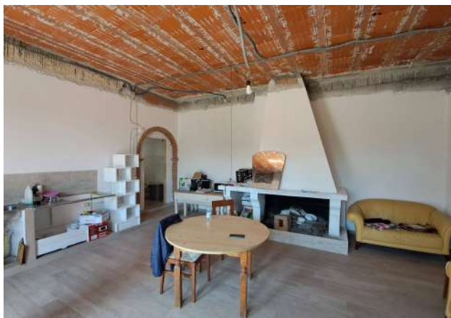
31. Cucina rustica vista verso il bagno 4.
