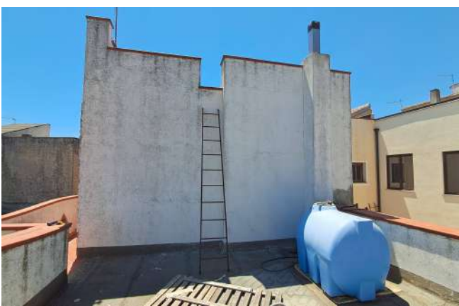
11. Accesso alla copertura del piano primo.
