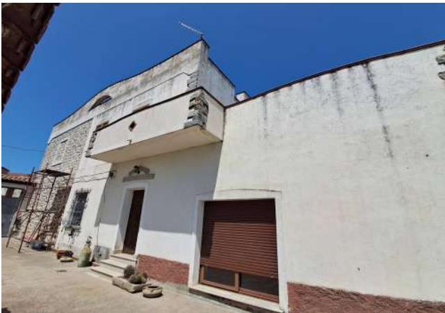
3. Vista Est con ingresso all'abitazione.
