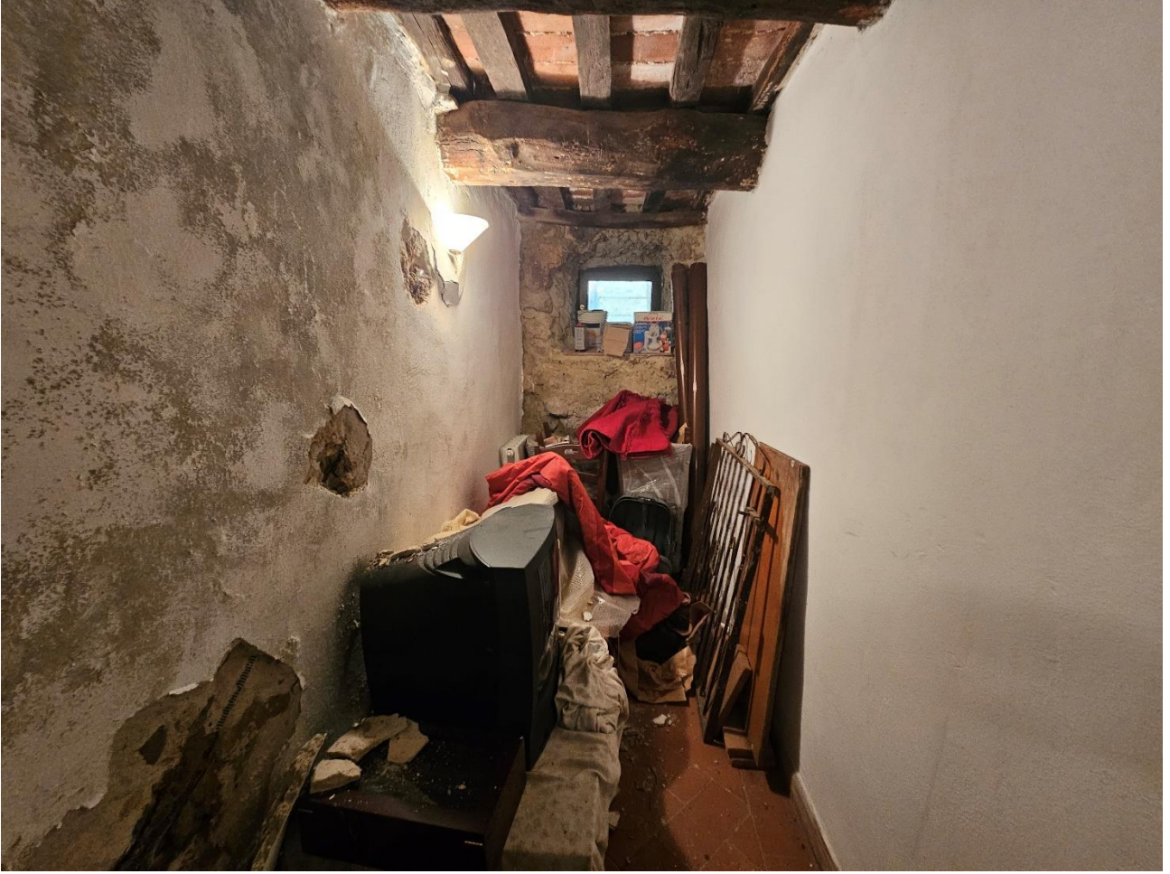
Locale terminale del monolocale
