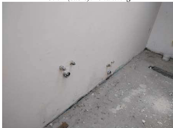
U.I. 1 (sub 6): servizio igienico
