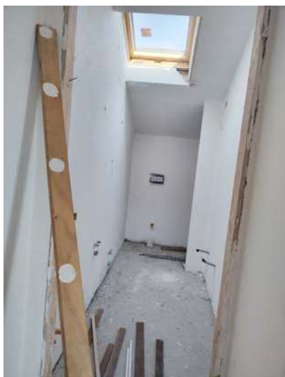
U.I. 1 (sub 6): servizio igienico
