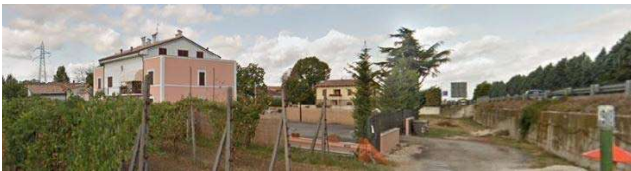
Vista della relazione tra l'edificio e la SS75 (a destra)
