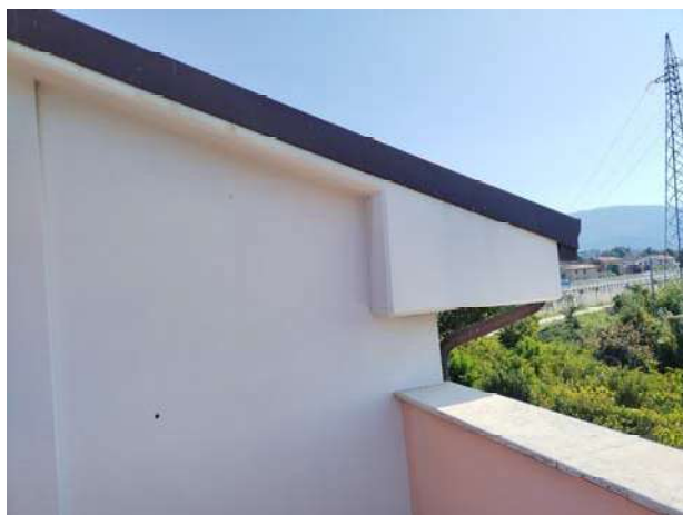
U.I. 2 (sub 7): particolare sporto di gronda
