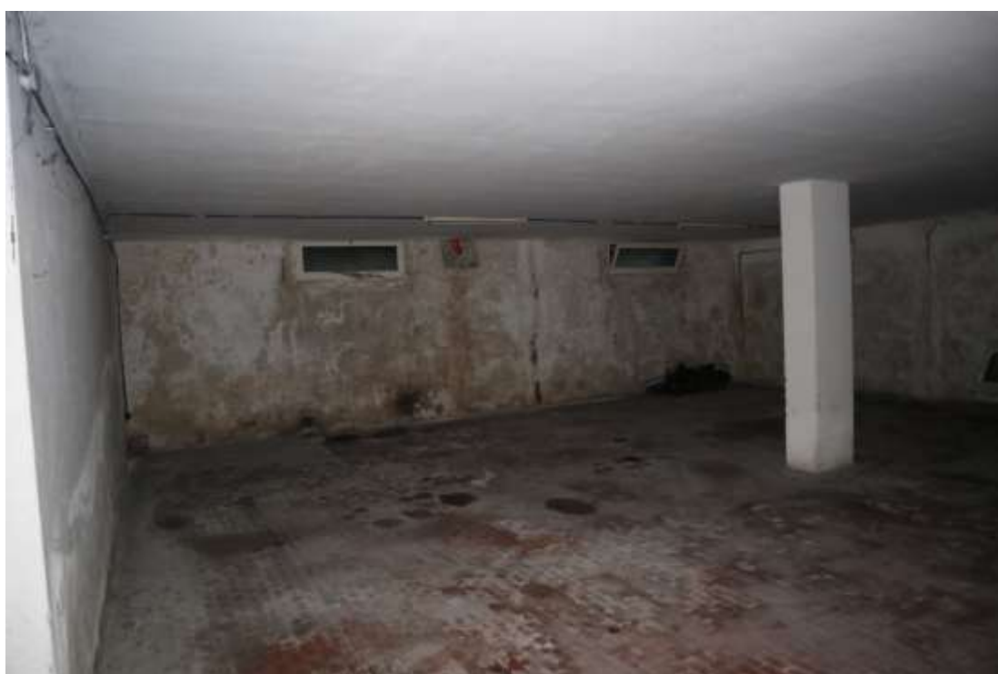
VISTE DELLA PARTE "BASSA" DEL LOCALE
