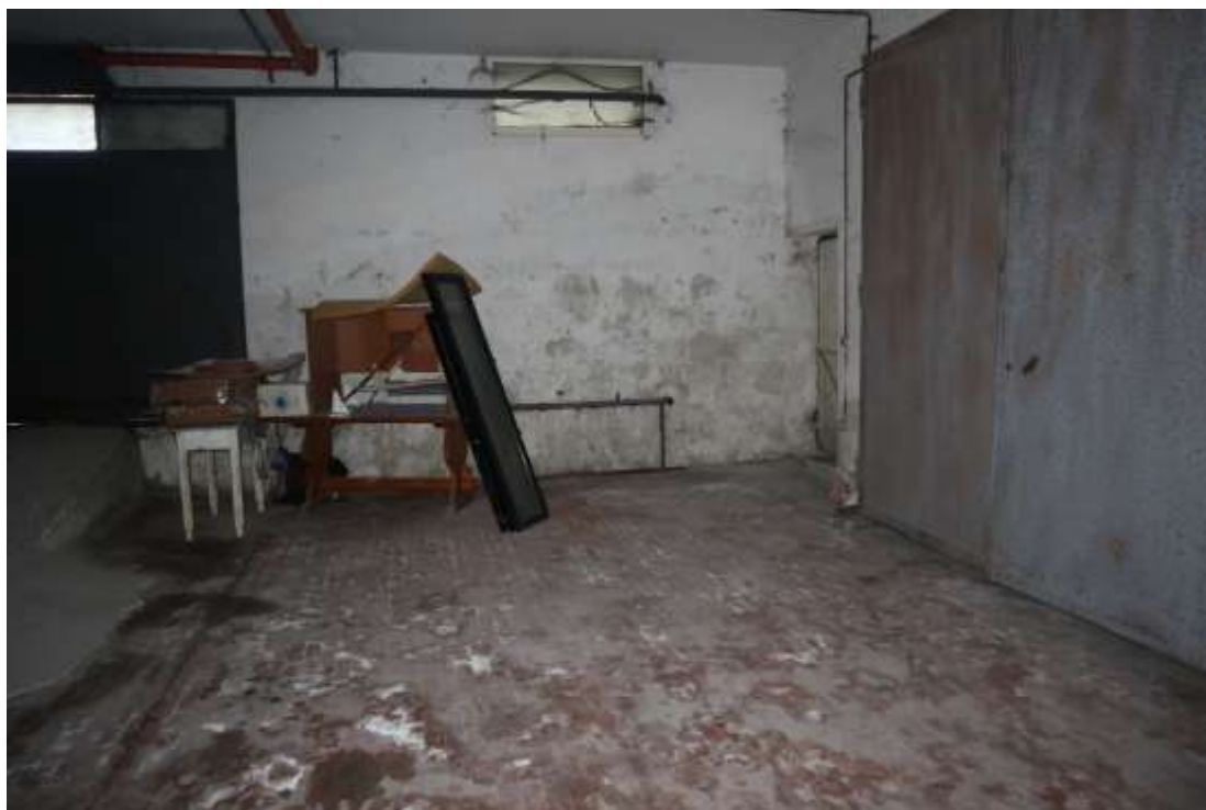
VISTA DEL LOCALE CON PRESENZA DI TUBAZIONI
