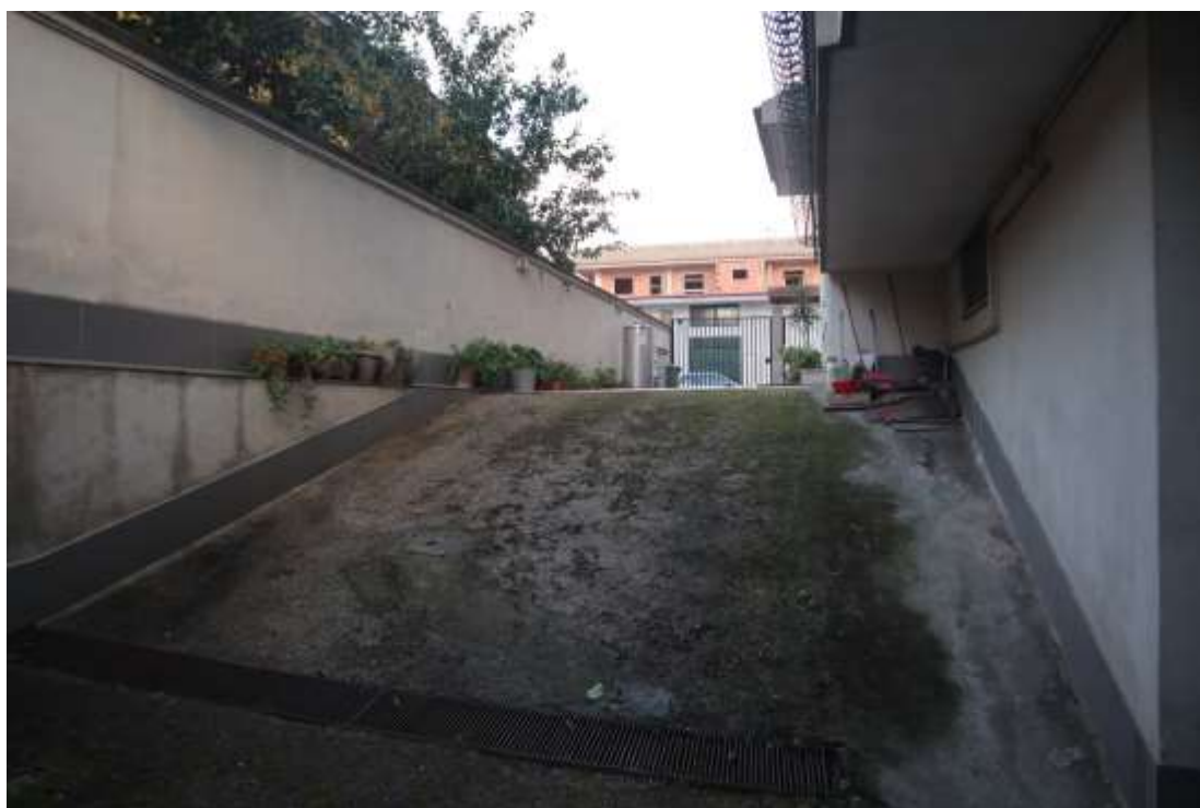
ALTRA VISTA DELLA RAMPA
