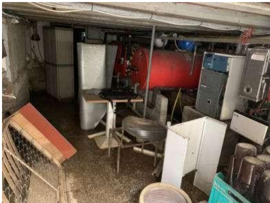
Foto 2: Vano Centrale Termica
