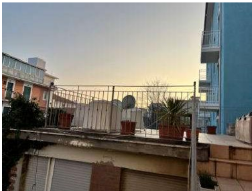
Foto 66 e 67: Copertura non accessibile dello studio utilizzata impropriamente come “terrazza”
