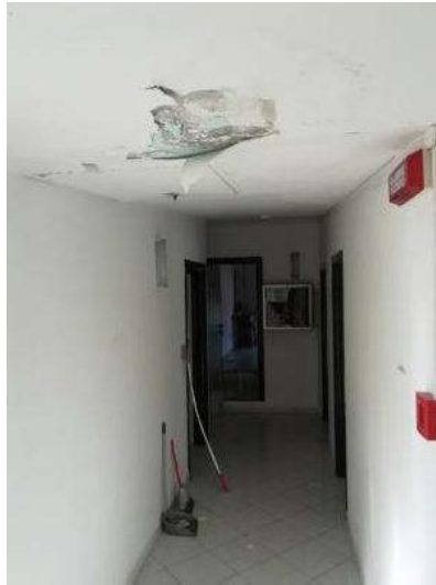
Foto 33 e 34: Infiltrazioni corridoio P4
