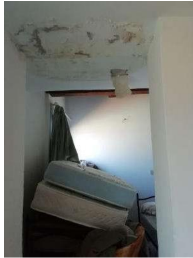
Foto 33 e 34: Infiltrazioni corridoio P4
