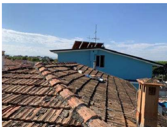
Foto 29 e 30: Porzione di tetto crollato
