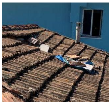
Foto 29 e 30: Porzione di tetto crollato
