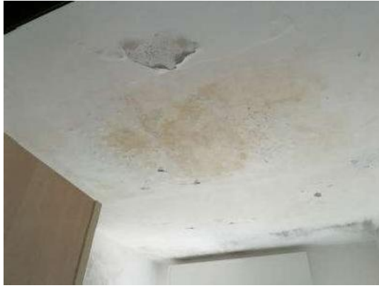
Foto 31: Infiltrazioni camera 313
