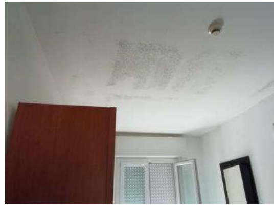
Foto 32: Infiltrazioni camera 314
