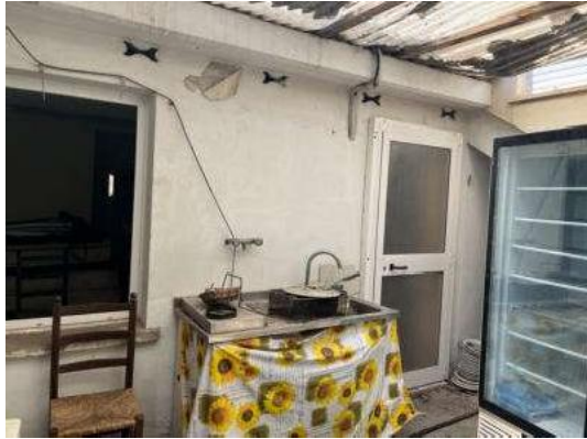
Foto 61 e 62: Corte sul retro – Tettoia precaria legno/pvc e tamponatura con infisso scorrevole legno/alluminio non legittimate
