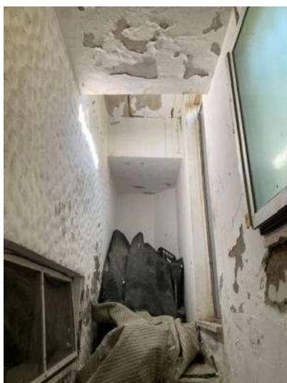
Foto 8: Scrostamenti/Infiltrazioni
