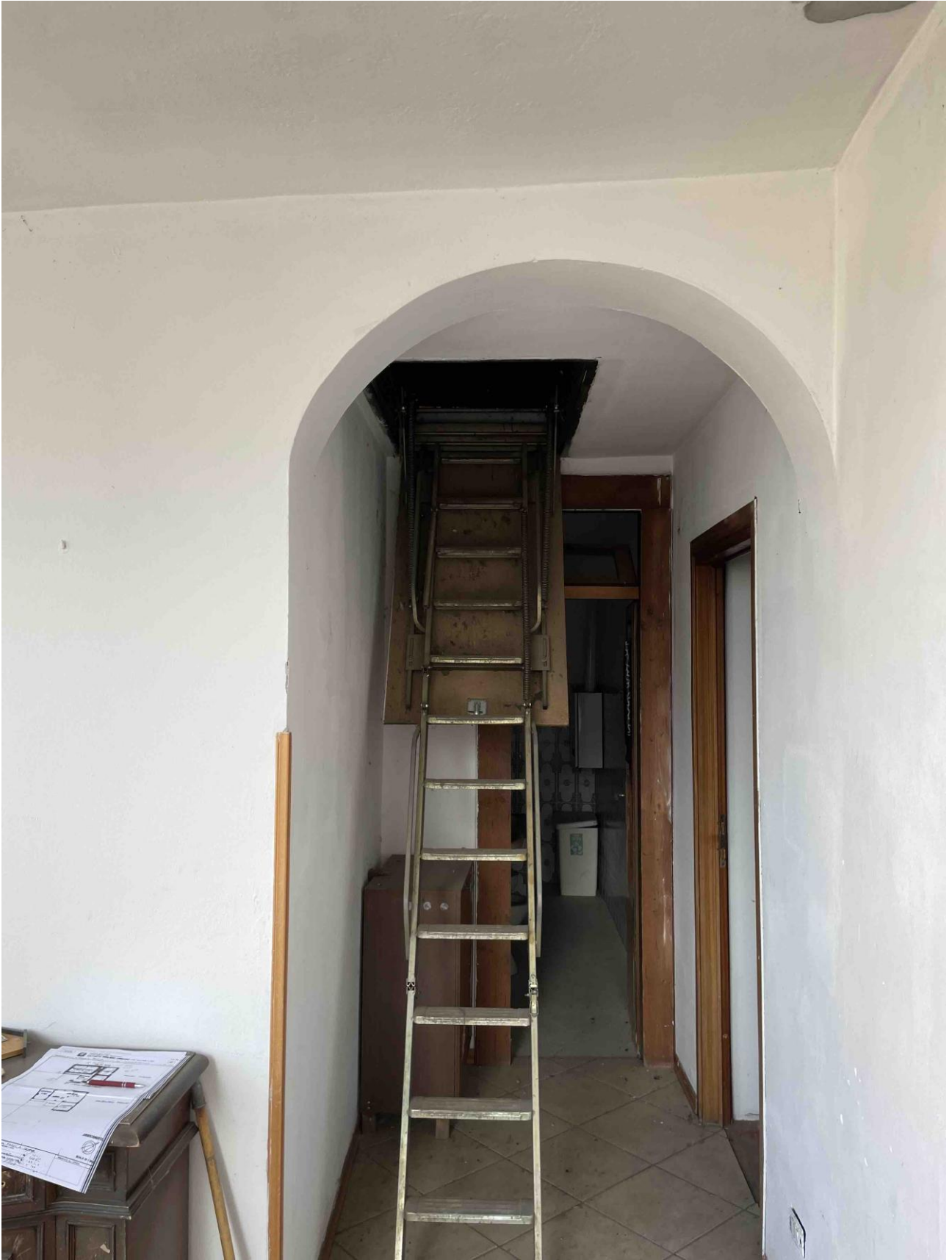
SCALA ACCESSO SOTTOTETTO
