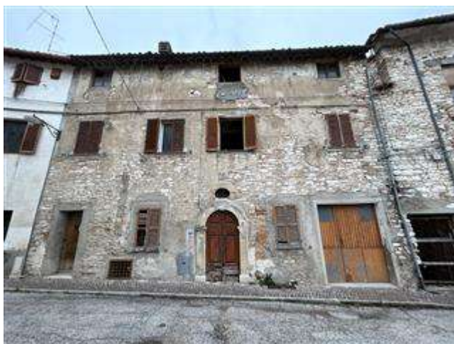
Fronte immobile su via delle Tinte
