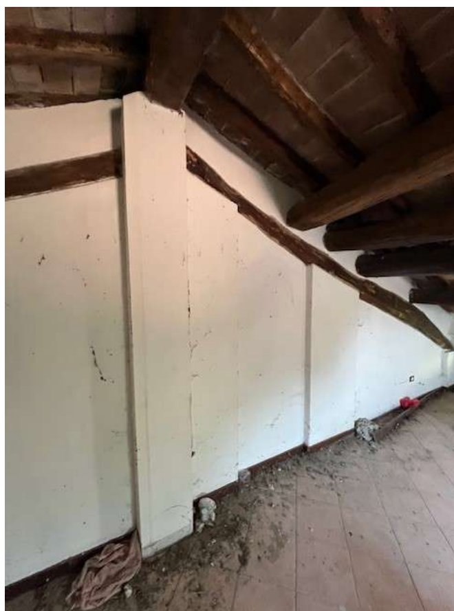
Fotografia 18 – Vista del locale soffitta
