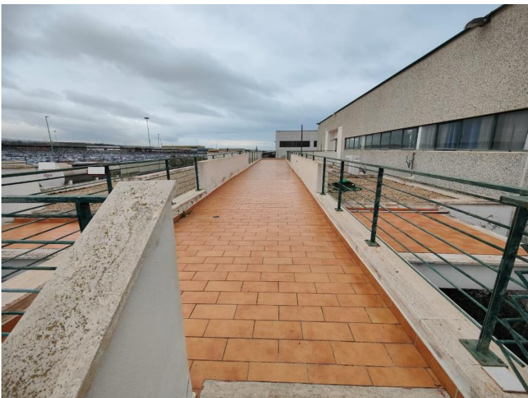
17 – esterno - terrazza di copertura zona uffici
