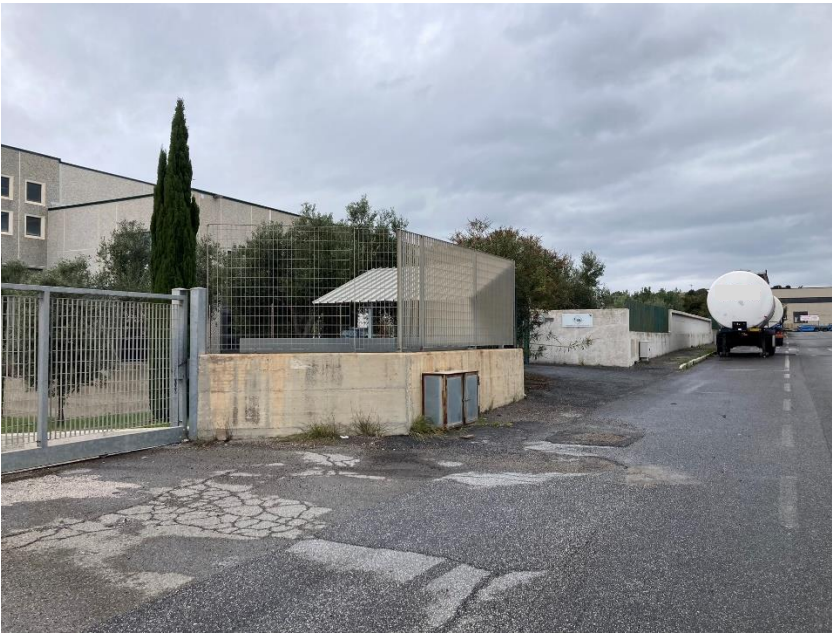
1 – vista edificio verso via Gian Mauro De Angelis D'Ossat
