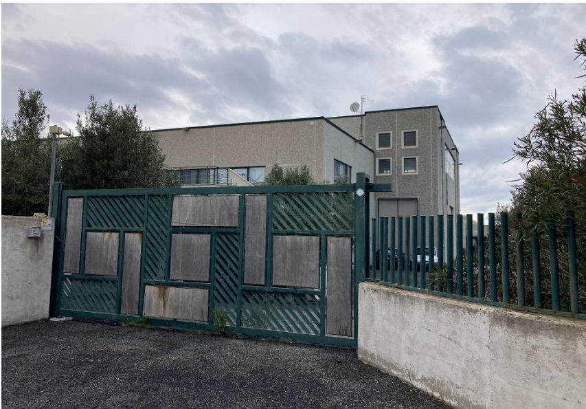
4 – altro ingresso, cancello carrabile, da via Alberto La Rosa
