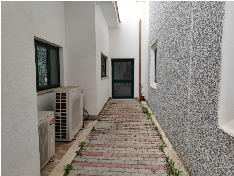
13 – esterno – corridoio fra zona uffici e capannone
