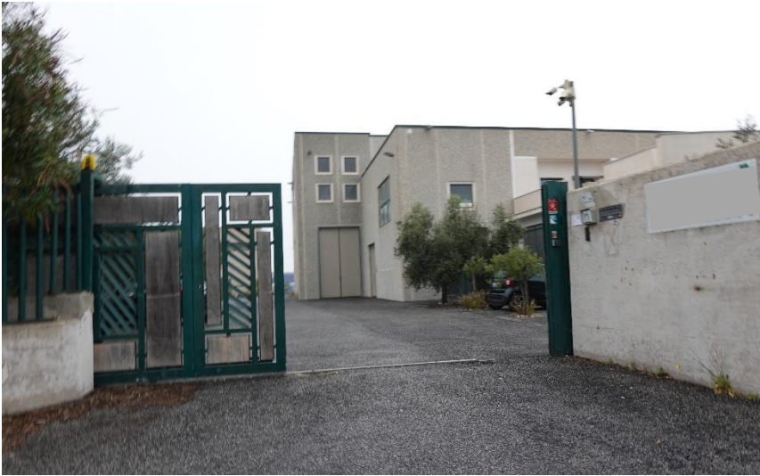
3 – ingresso principale, cancello carrabile, da via Alberto La Rosa
