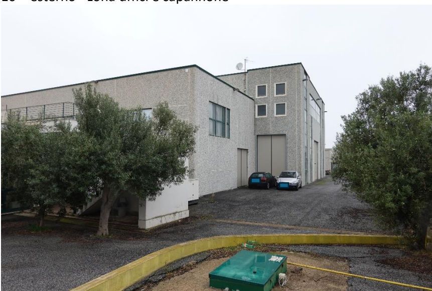
11 – esterno - vista capannone
