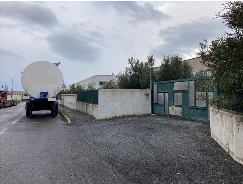
2 – vista edificio verso via Sandro Ferri
