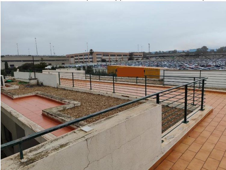
19 – esterno - terrazza di copertura
