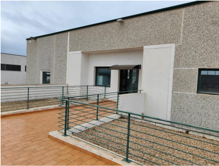
18 – esterno – accesso quota soppalco dal terrazzo di copertura
