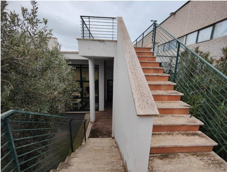
15 – esterno - scala verso la terrazza di copertura zona uffici
