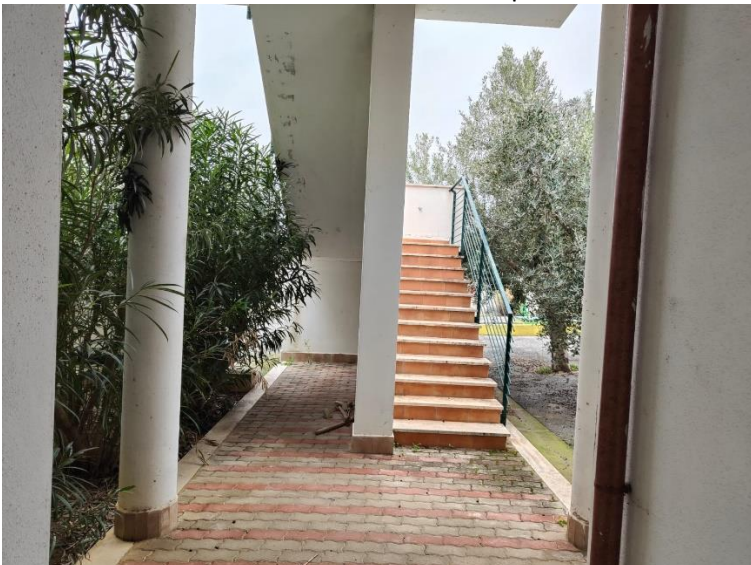
14 – esterno – scala collegamento terrazza di copertura zona uffici
