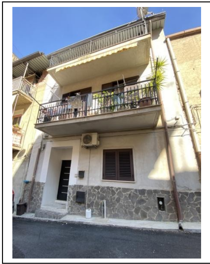
Foto 1 - Prospetto su via Isonzo
