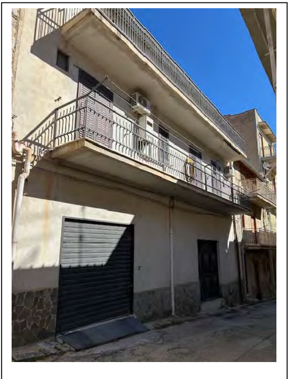
Foto 2 – Esterno – Prospetto su via Notar G. Vaccaro
