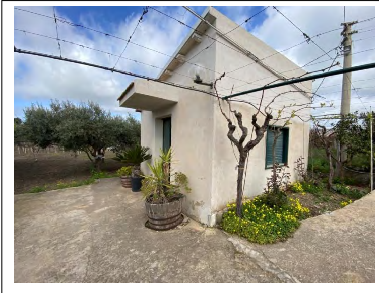
Foto 14 – Altro corpo di fabbrica
