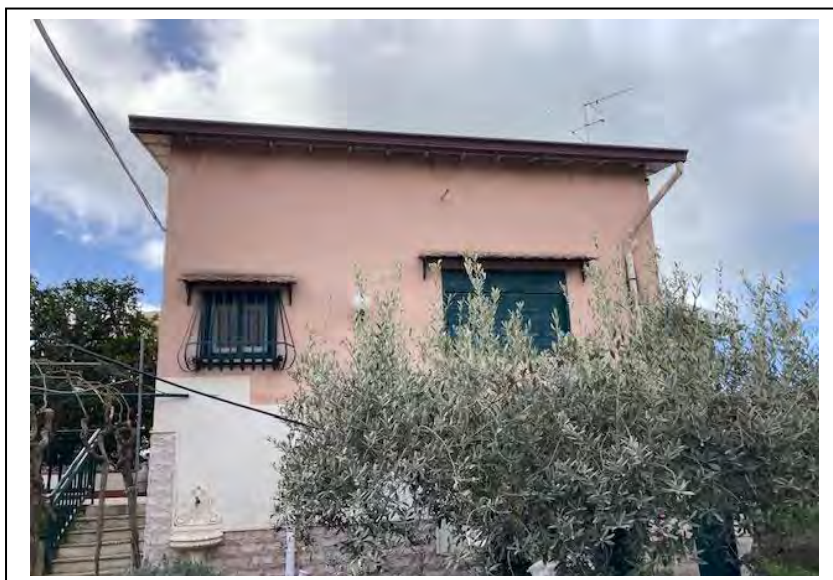
Foto 3 – Fabbricato Prospetto Nord/Est
