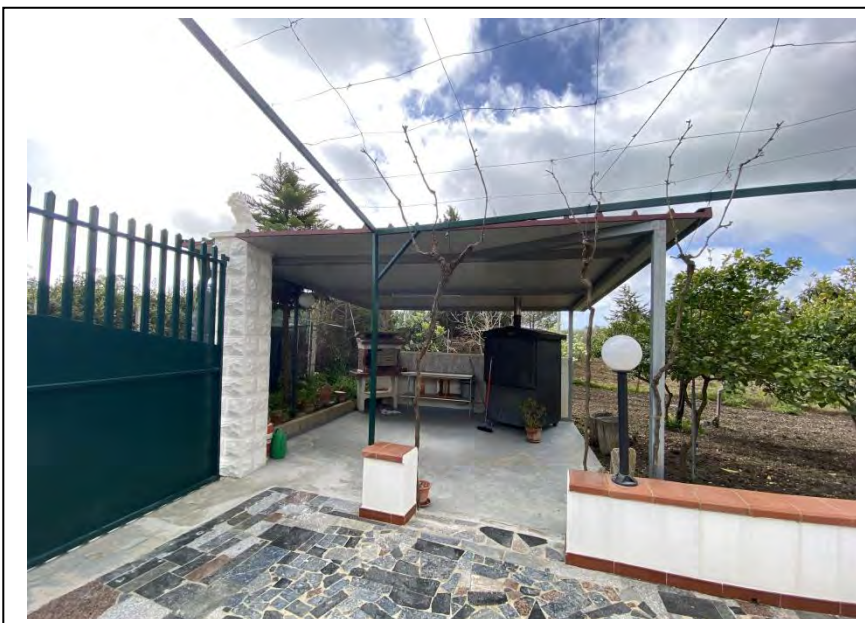
Foto 19 – Tettoia aperta sui lati
