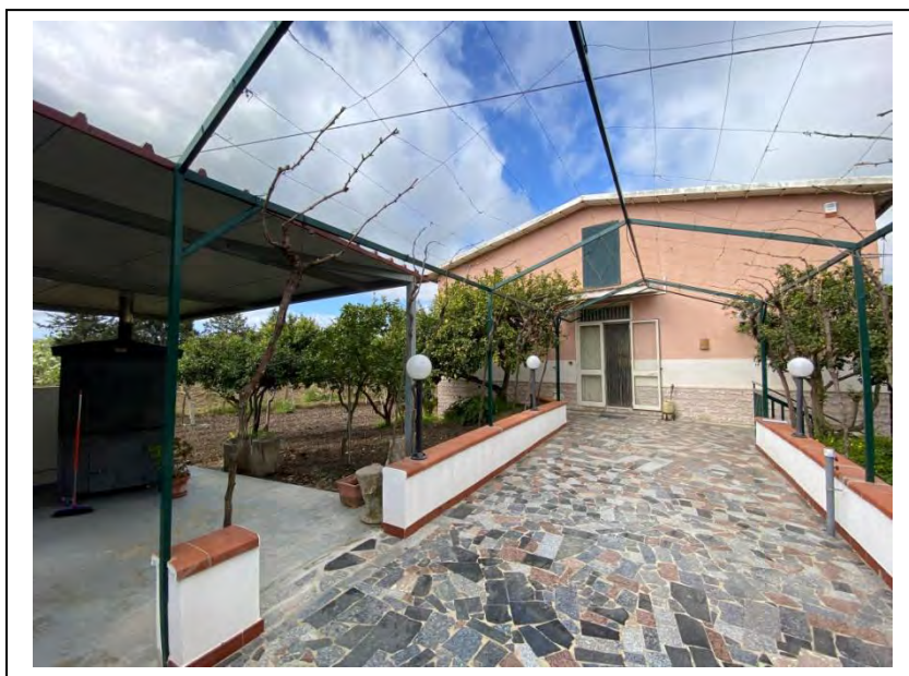
Foto 2 – Fabbricato Prospetto Sud/Est
