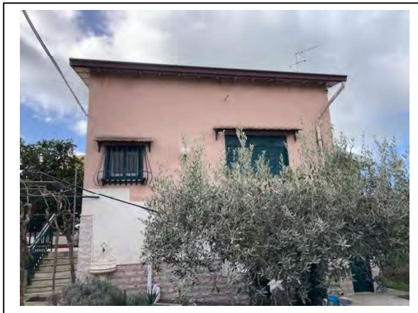
Esterno fabbricato Prospetto Nord/Est
