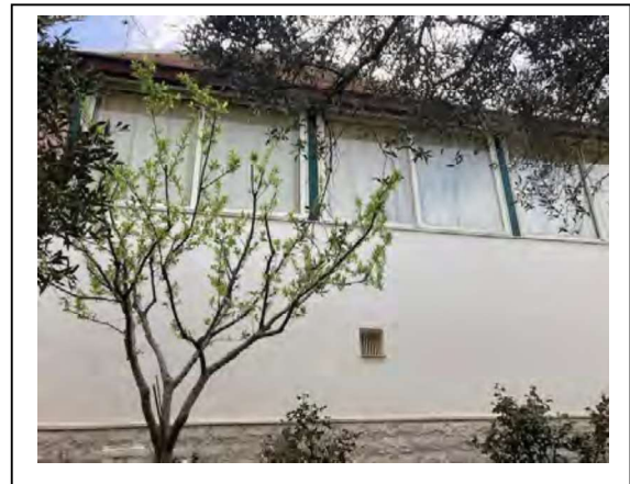
Esterno retro fabbricato Prospetto Nord/Ovest
