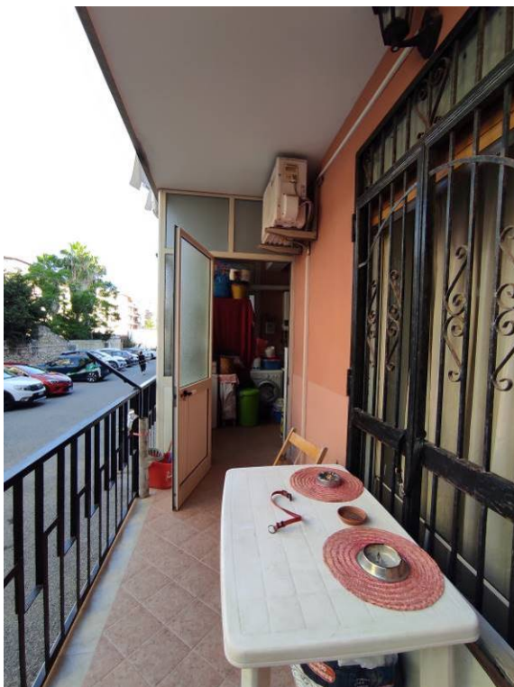
Foto 11 – Porzione aperta del balcone 02
