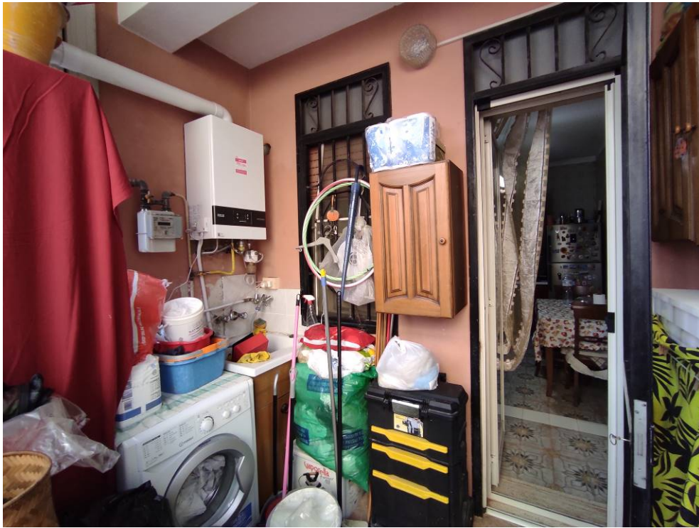
Foto 5 – Porzione chiusa del balcone 02
