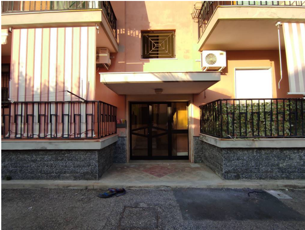
Foto 1 – Portone di ingresso al vano scala B di Via Noto 10
