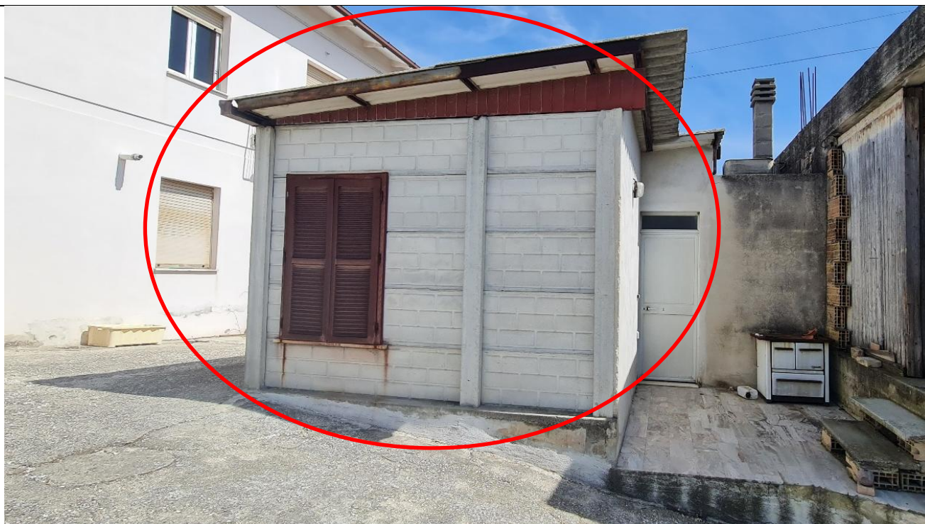
Immobile 4 in prefabbricato in c.a., contiguo al fabbricato al grezzo con tamponatura (Sub 3 e sub 5)
