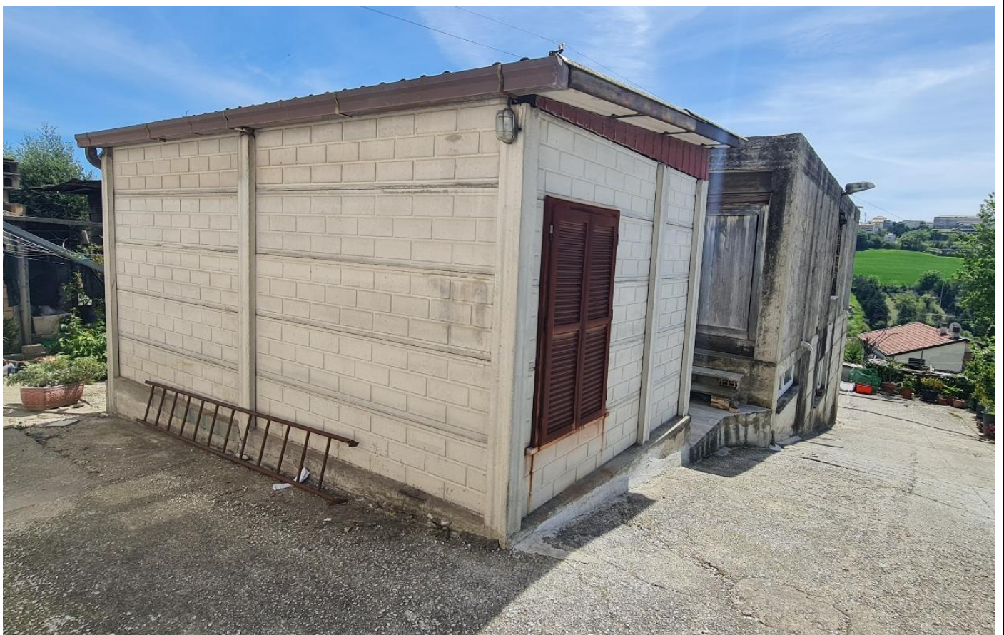
Edificio al grezzo in c.a. con edificio di minore grandezza, contiguo e con struttura in prefabbricato dotato di manto di copertura in cemento amianto, ovvero eternit
