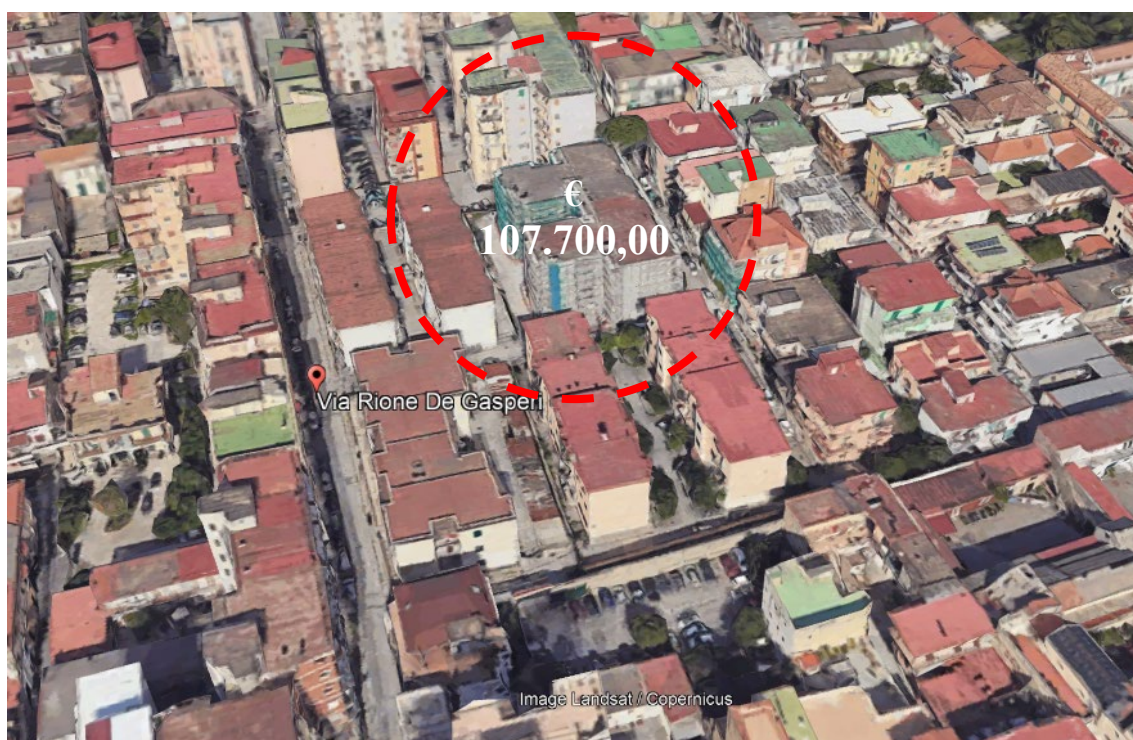
Viste dall'alto del fabbricato di cui l'appartamento pignorato è parte integrante
