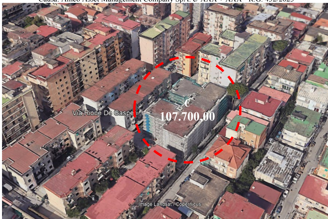
Viste dall'alto del fabbricato di cui l'appartamento pignorato è parte integrante
