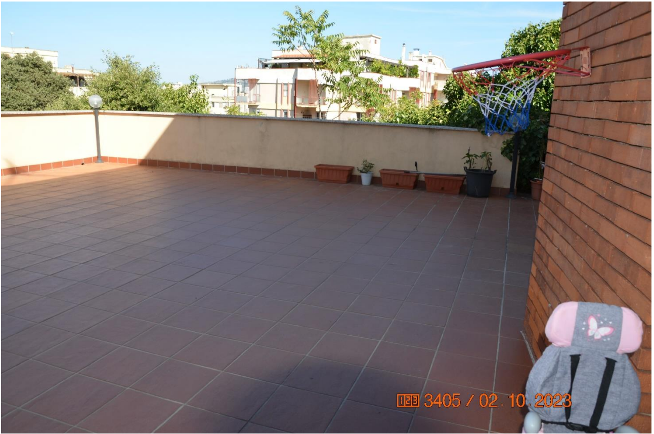
Veranda su solaio garage
