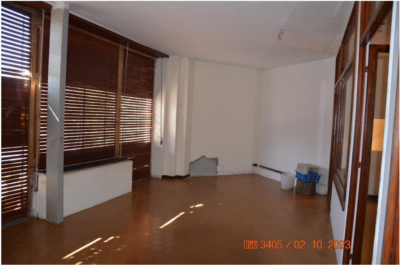
Particolare piano terra veranda coperta
