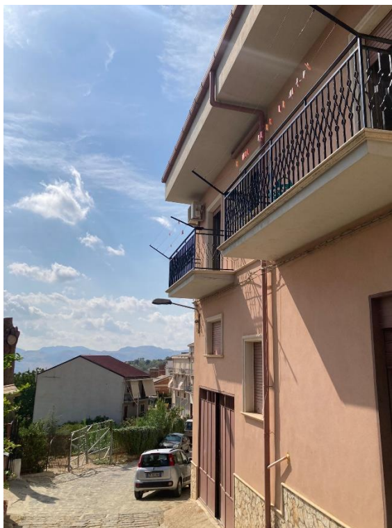
FOTO N.2 Via Cav. V. Veneto
