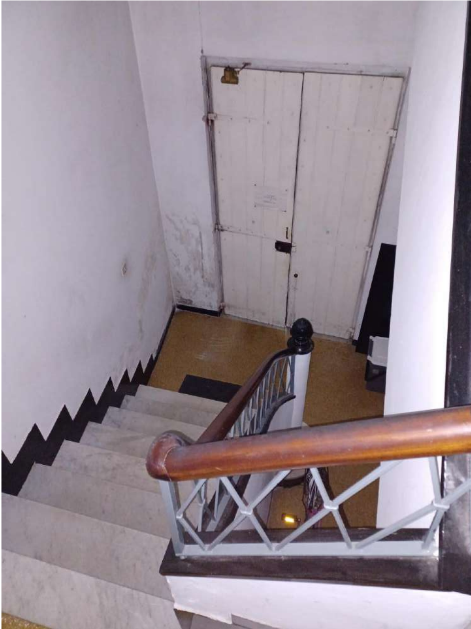
Vista interna del corpo scale
