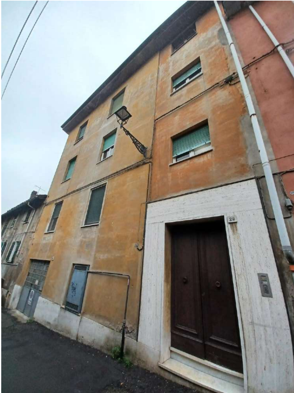
Vista generale dalla viabilità di accesso su Via Palestro
