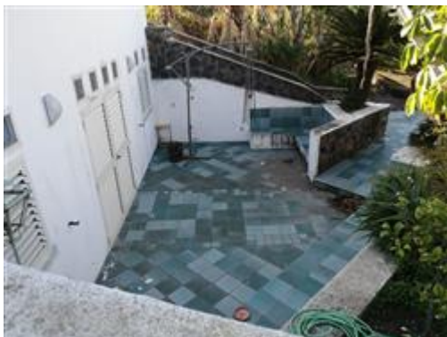
ingresso deposito grande con terrazzo
