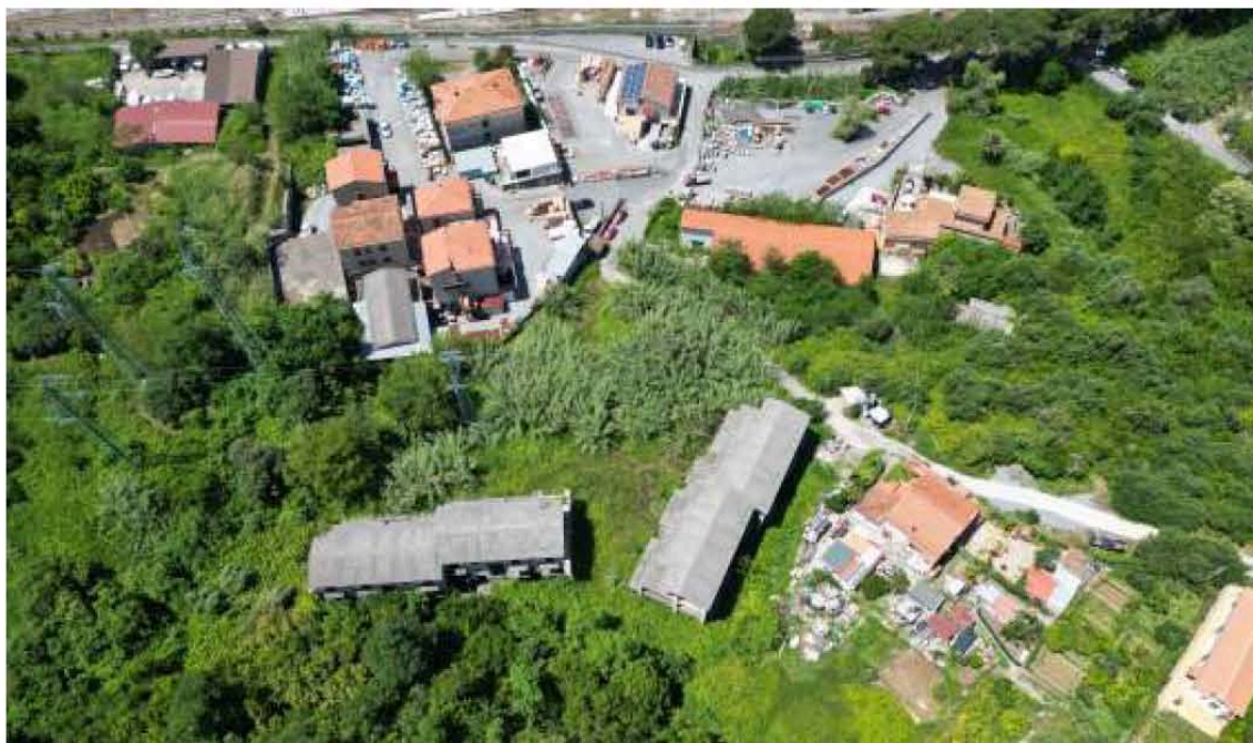
Fig. 1.Foto aerea immobili siti in Maratea (Pz) loc. Profiti. (sopralluogo 23/10/2023)
