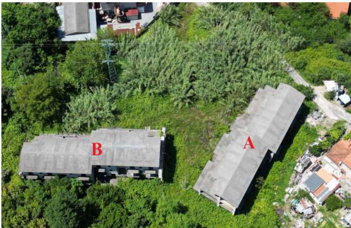
Fig. 5.Foto aerea con indicazione dei due manufatti.
