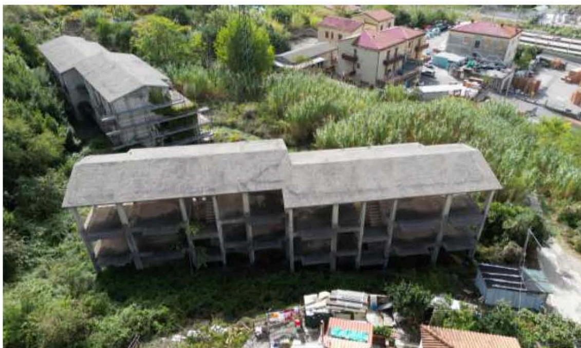
Fig. 2.Foto aerea immobili siti in Maratea (Pz) loc. Profiti. (sopralluogo 23/10/2023)
