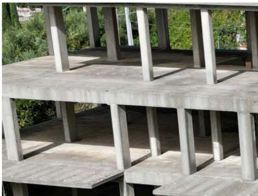
Fig. 7. Foto interna Fabbricato A. (particella 2653)
