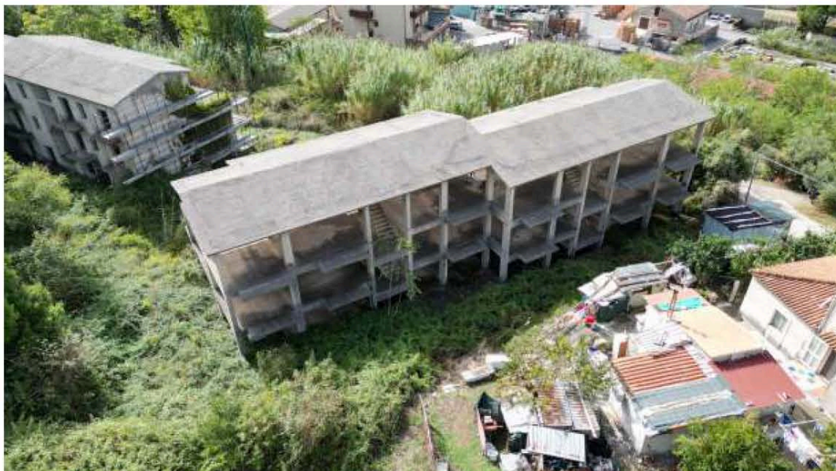
Fig. 3.Foto aerea Corpo A (sopralluogo 23/10/2023)
