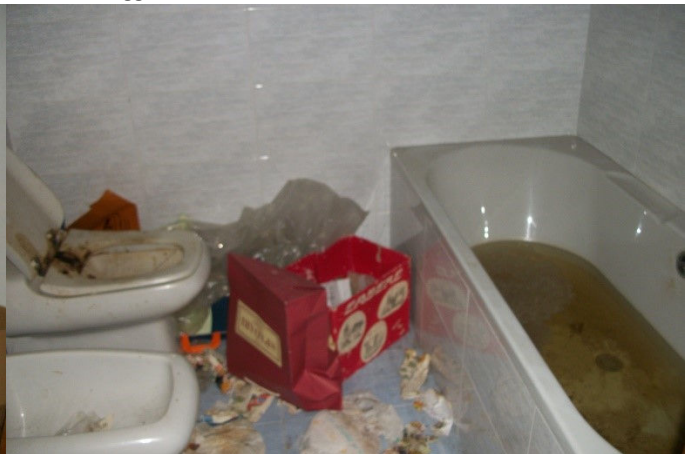
f.20 vista bagno al piano primo
