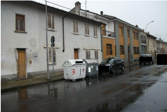
f.1 vista fabbricato dalla via Mauro Angeleri
