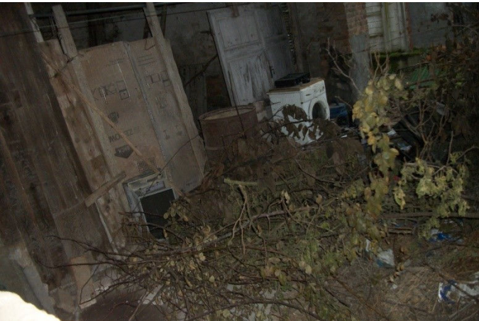
f.13 vista interno fabbricato rurale
