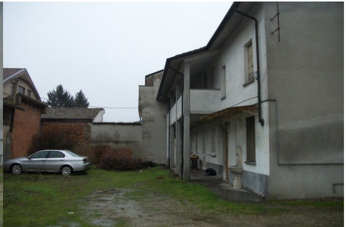
f.4 vista portico con balcone superiore
