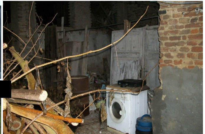
f. 12 vista interno fabbricato rurale
