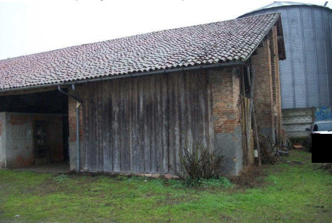
f.11 vista del fabbricato rurale
