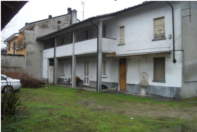
f.3 vista fabbricato dalla corte interna
