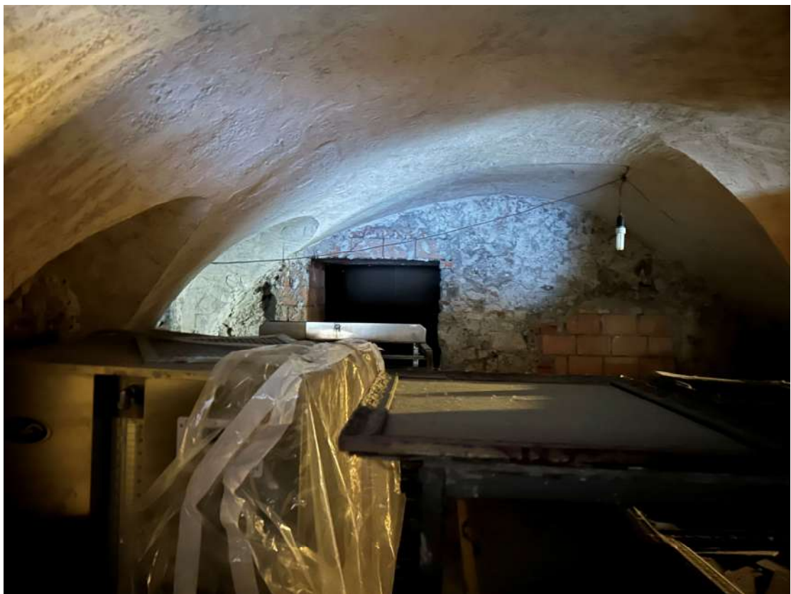
Foto 16 – Retro negozio sub. 702
