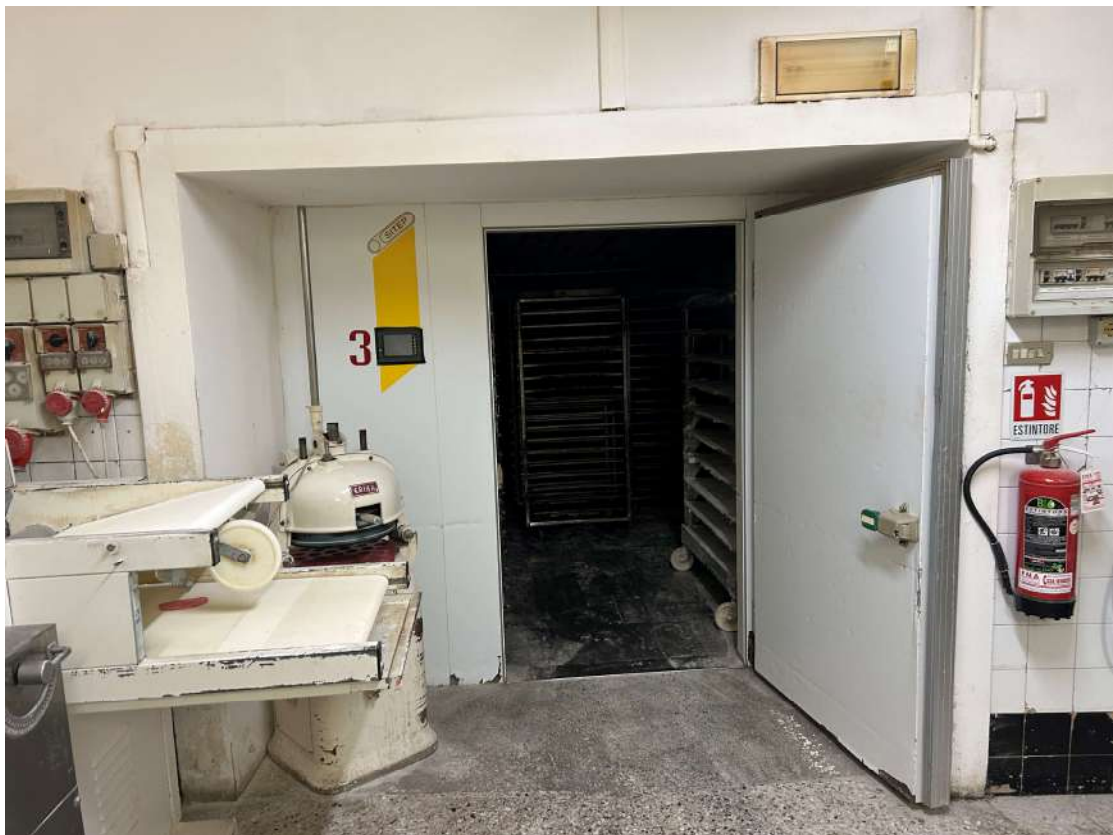
Foto 6 – Celle lievitazione sub. 703
