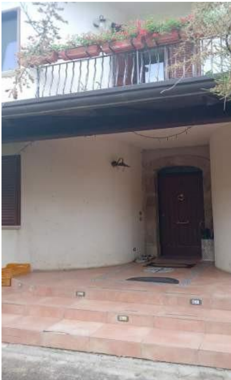
Ingresso Piano terra - Lato Nord-Est
