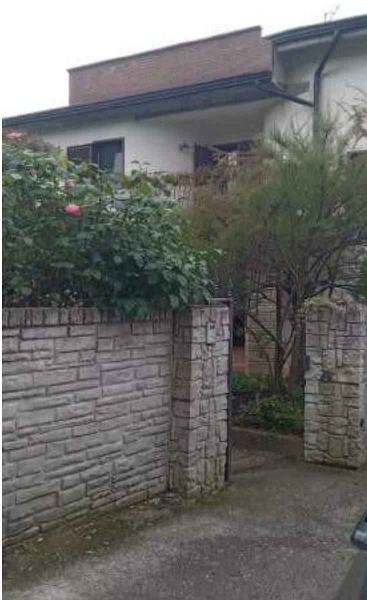
Cancelletto di ingresso pedonale-Lato Nord
