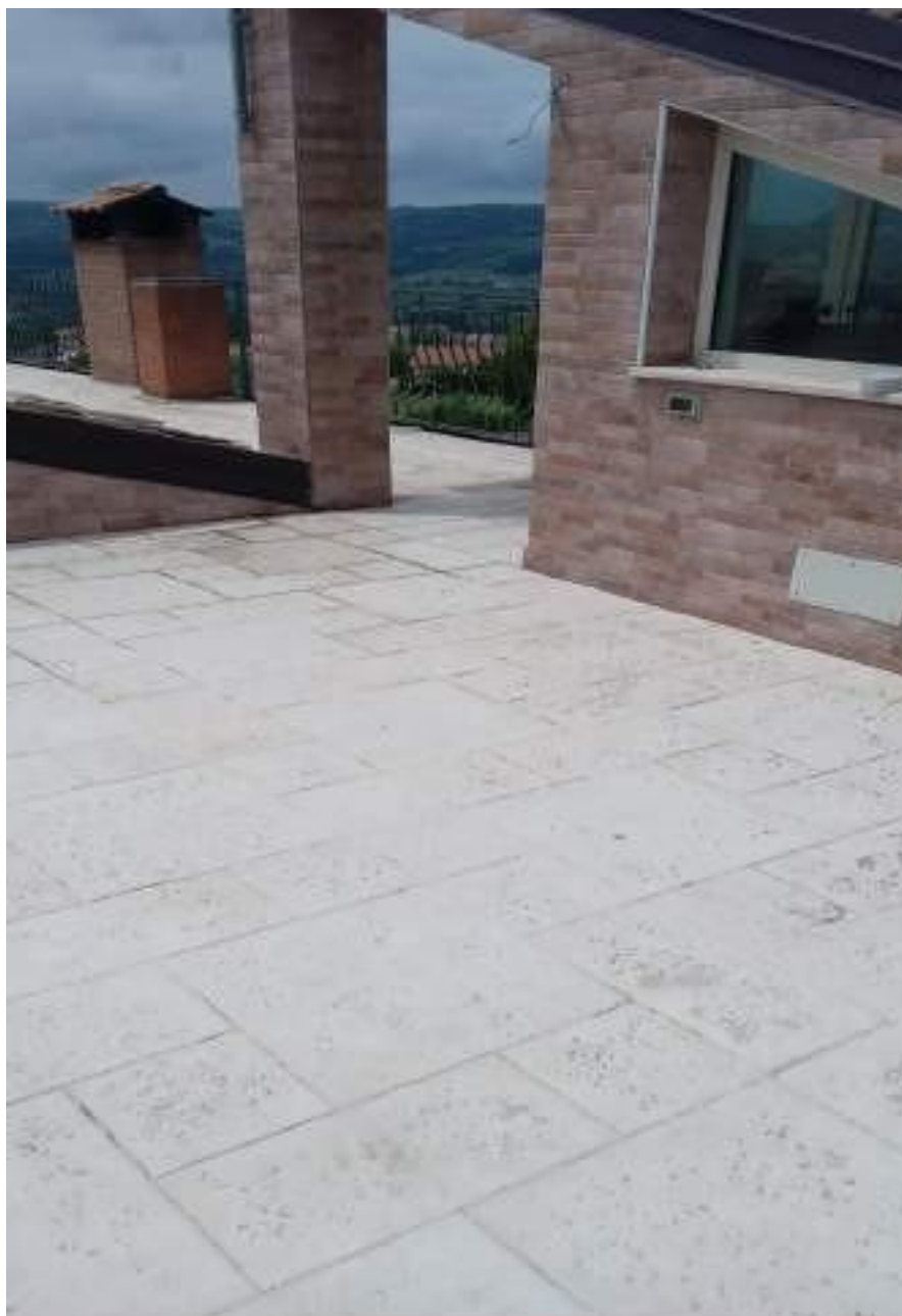
terrazzo in copertura
