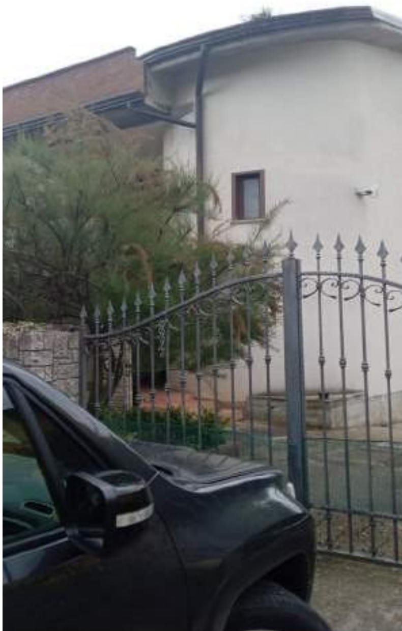
Cancello di ingresso- Lato Nord
