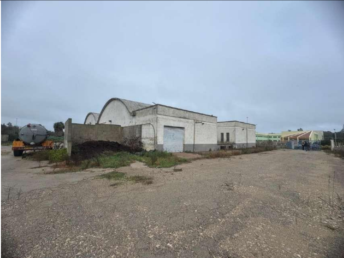
9. Prospetto sud-est e, a sinistra, muratura a C costruita abusivamente
