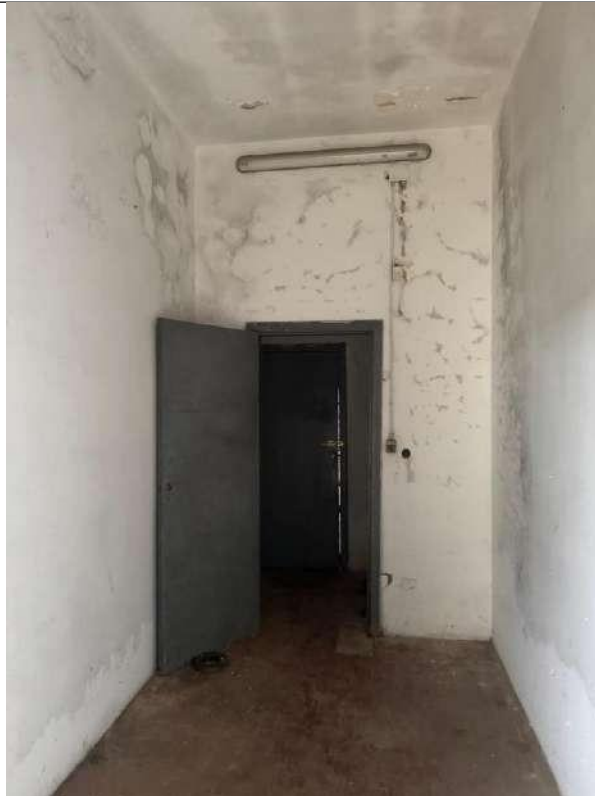
14. Vista dall'interno del bagno verso il corridoio
