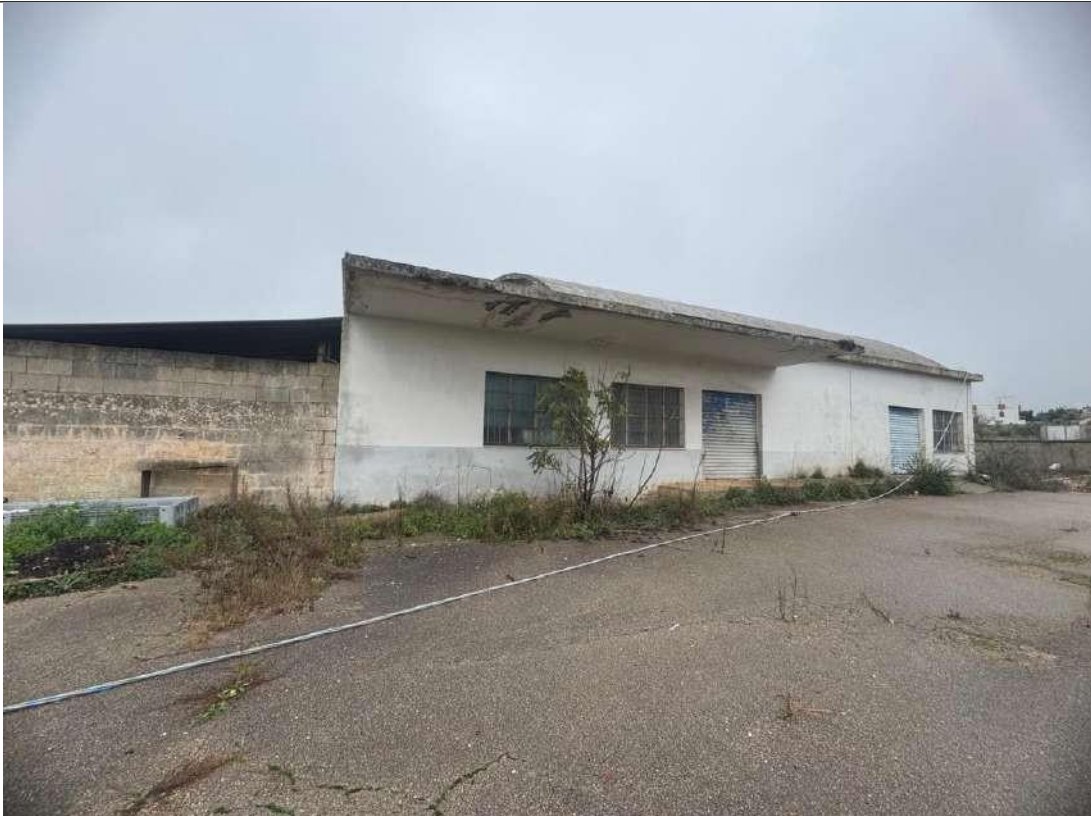
4. Prospetto nord-ovest e, a sinistra, parte del muro costruito abusivamente su cui sono appoggiate le tettoie abusive
