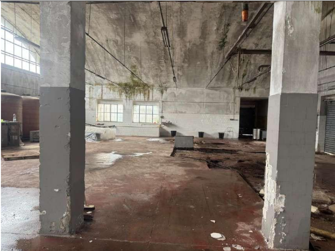
12. Interno del locale lavorazione con vista sulle finestre esposte a sud-est e sull'accesso al locale deposito (a destra)
