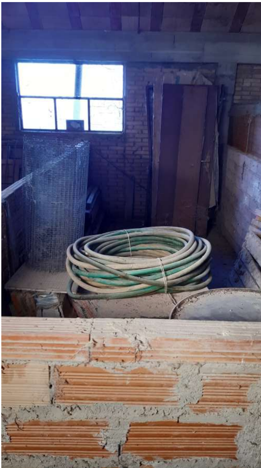
secondo edificio - ripostiglio
