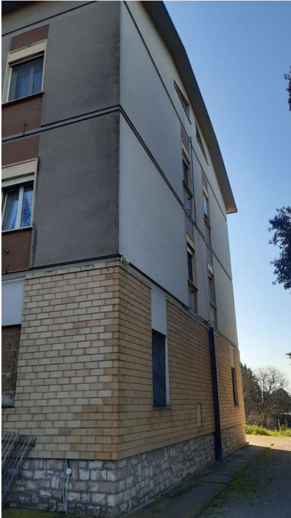
edificio principale - facciata ovest
