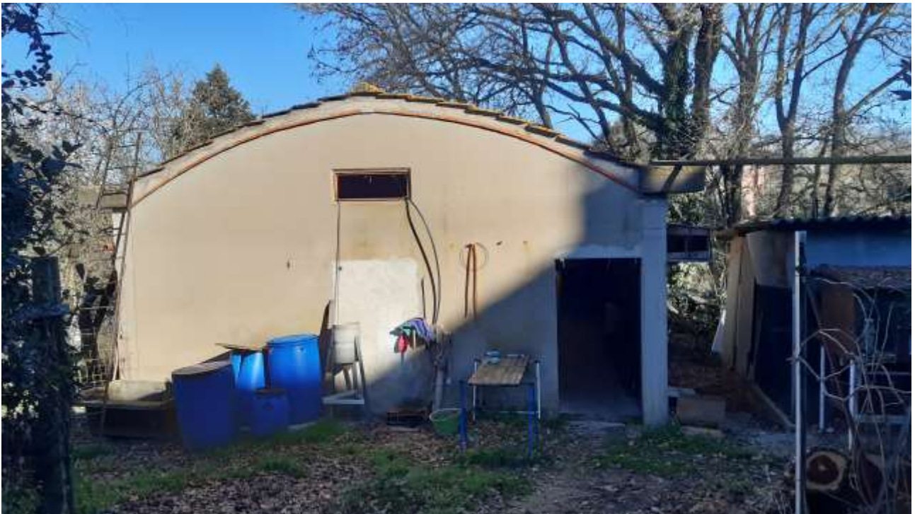
secondo edificio - facciata sud
