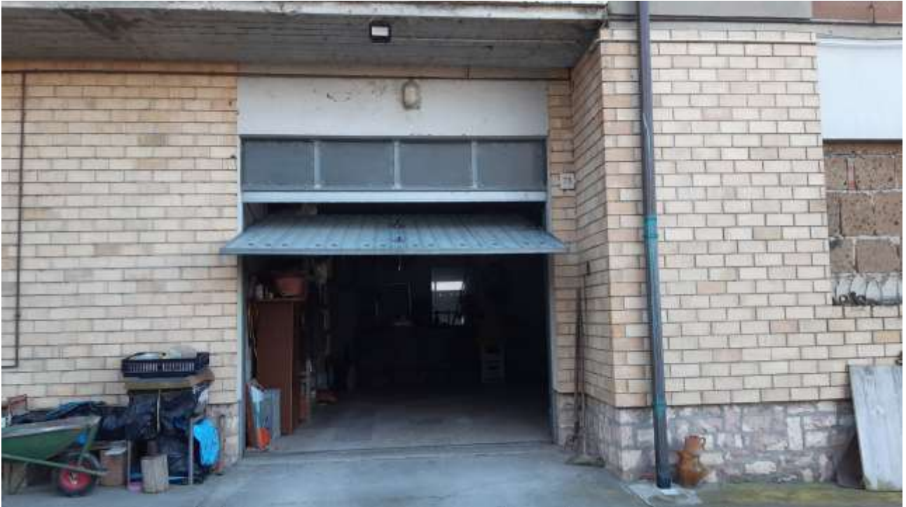
edificio principale - facciata nord - ingresso garage
