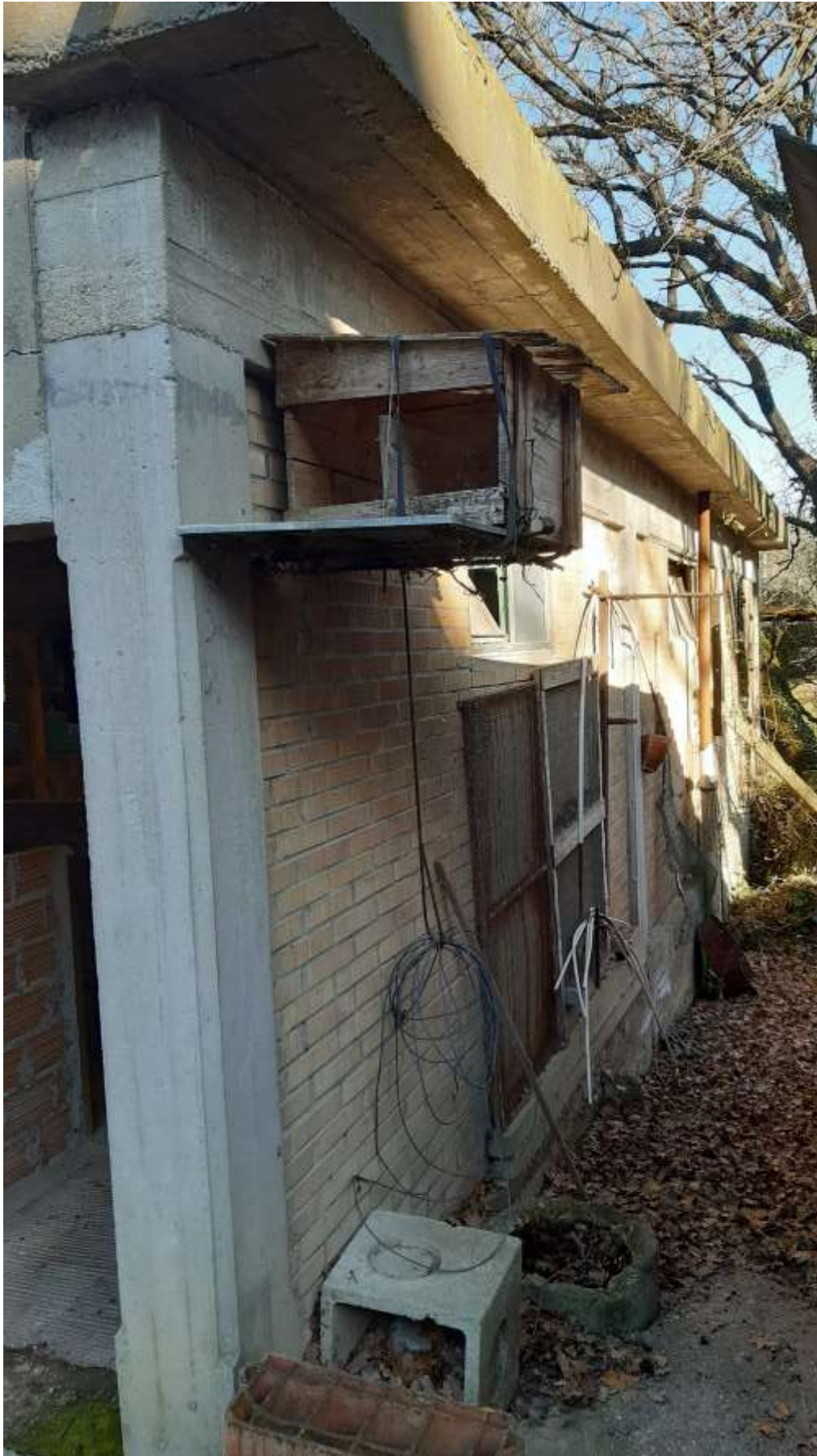
secondo edificio - facciata est
