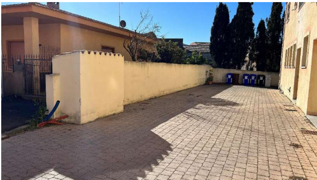
Figura 8 – Viste esterne del fabbricato all'interno del quale sono presenti i beni oggetto di elaborato peritale
