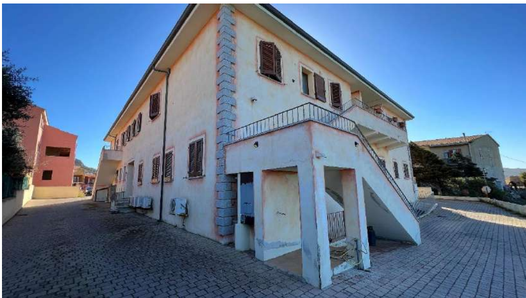
Figura 7 – Viste esterne del fabbricato all'interno del quale sono presenti i beni oggetto di elaborato peritale
