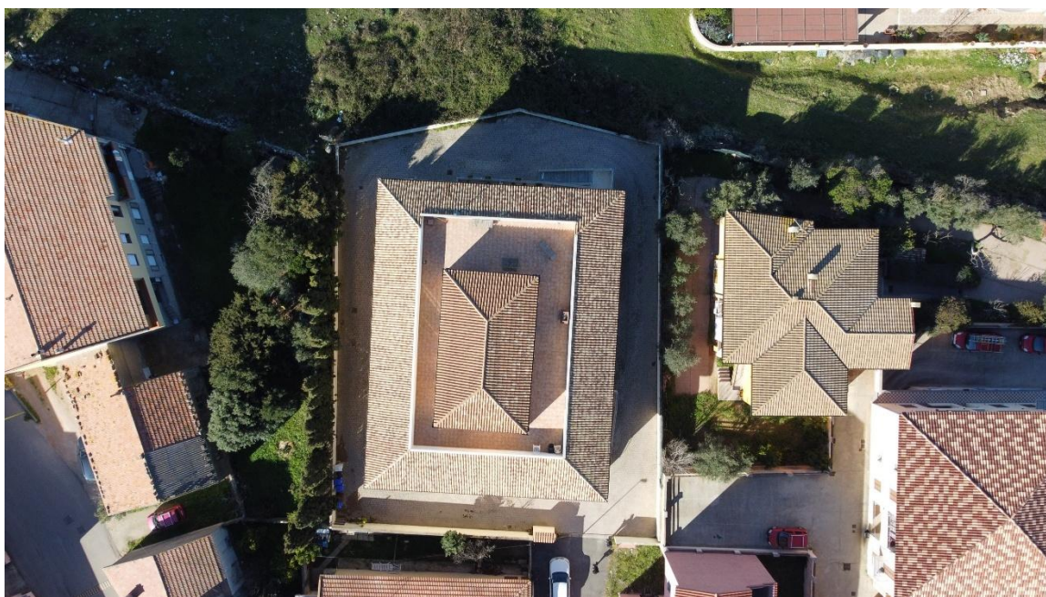
Figura 3 – Ubicazione – vista area del fabbricato che ospita l'unità immobiliare oggetto del presente elaborato peritale
