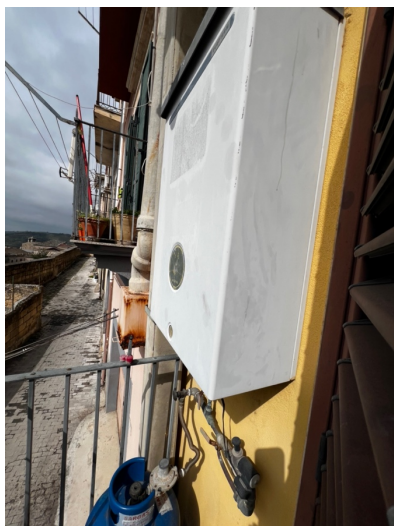
Figura 8 – Ballatoio lato sud-ovest
