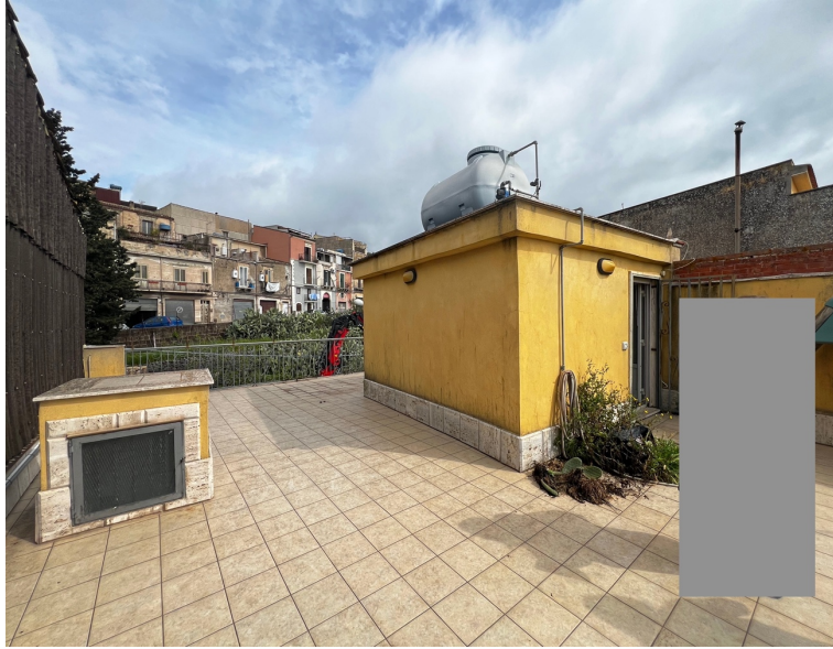
Figura 3 – terrazza al piano secondo
