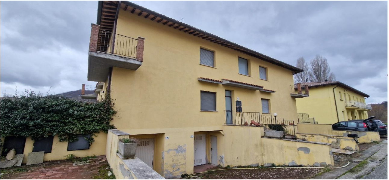
Figura 25. Foto vista esterna
