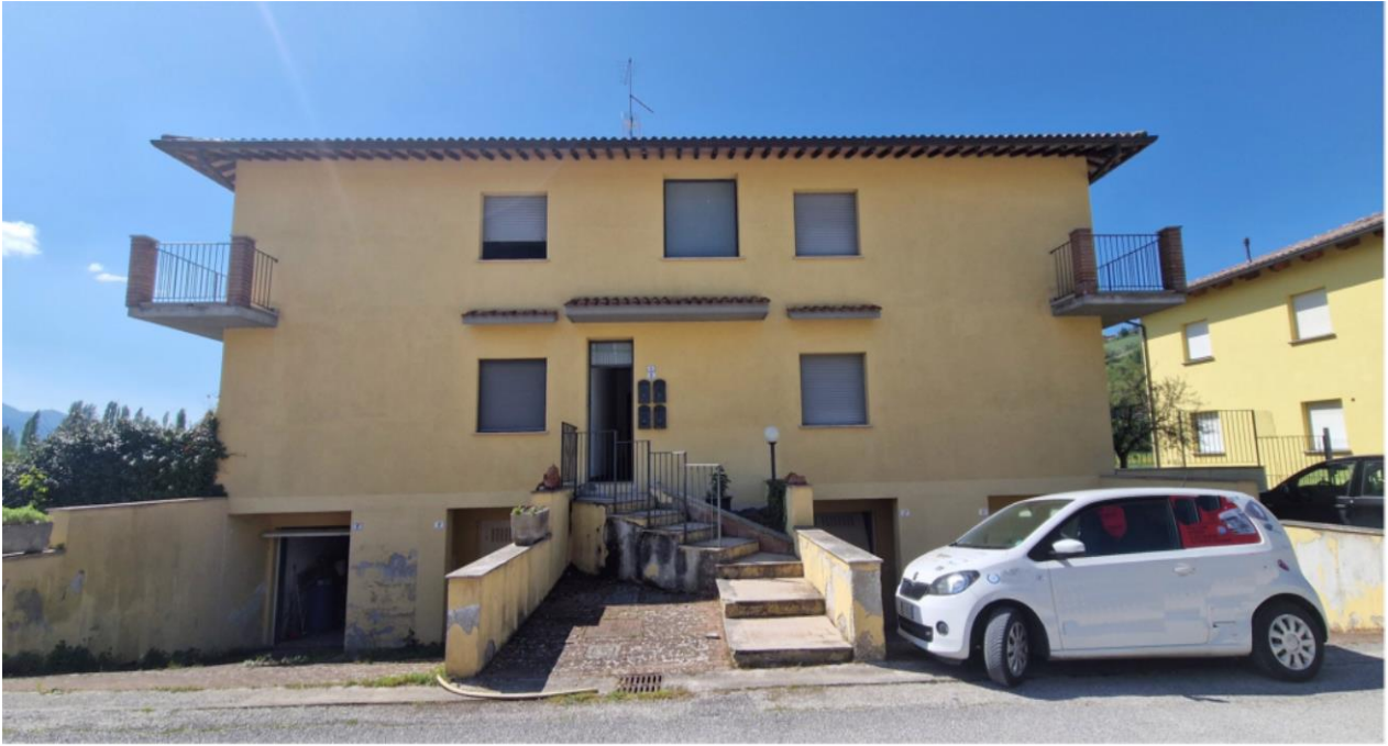
Figura 6. Foto vista esterna
