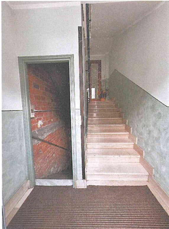
Vano scala e accesso alle cantine
