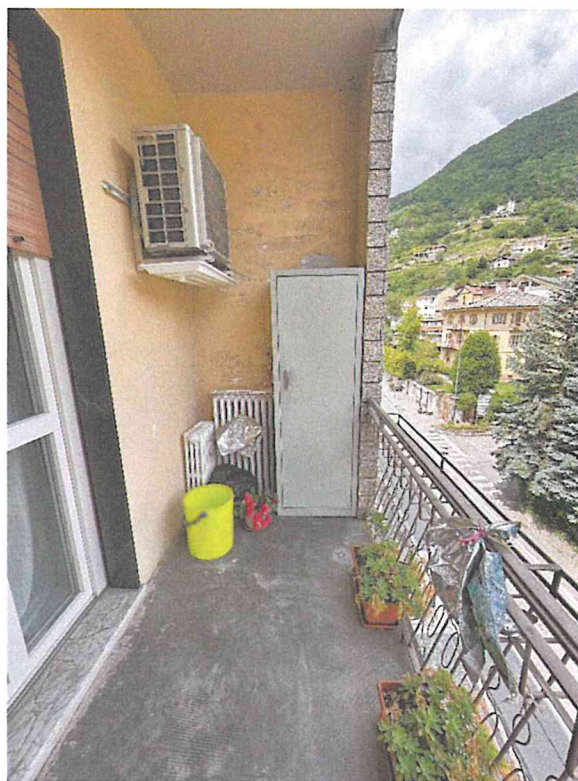
Balcone su via e radiatori rimossi
