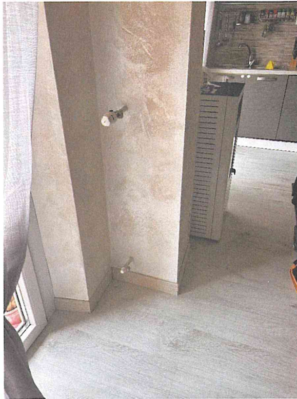
Rimozione termosifoni
