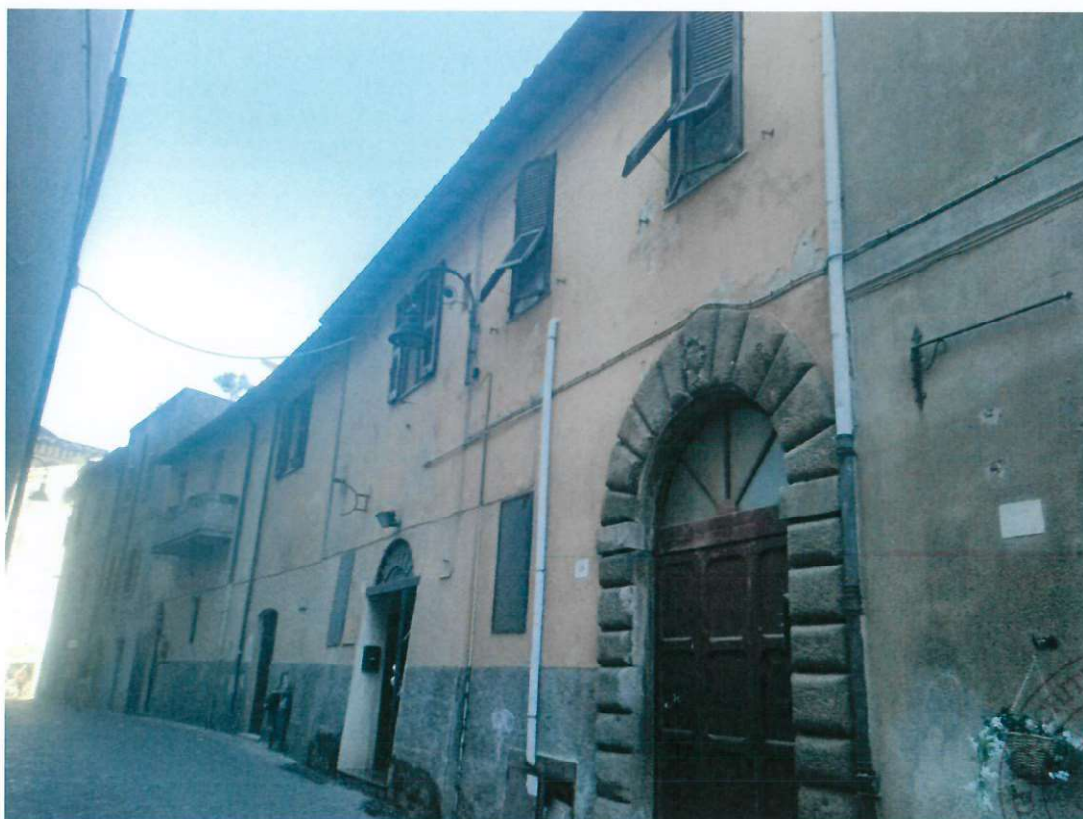
Foto 15 – Foto esterna su via Umberto I 16
