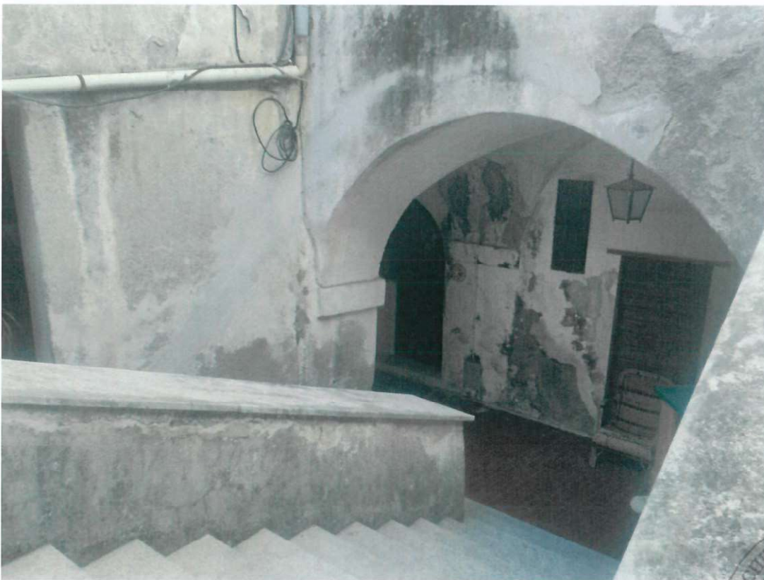
Foto 13 – Foto esterna scala e androne comune a tutti gli immobili
