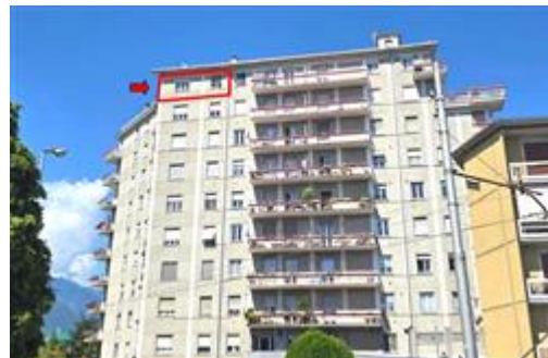
Vista Est Condominio "Belvedere"
