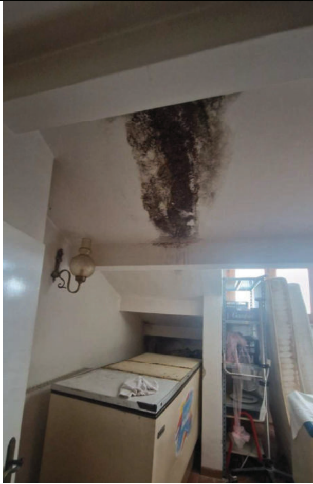
Viste interne zona soffitta
