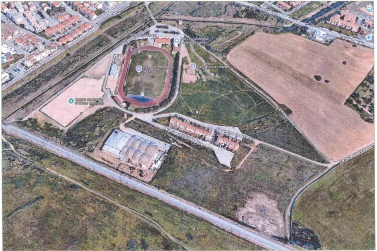
Foto n° 3: Vista aerea 3d della zona (fonte Google Earth – immagine anno 2024)
