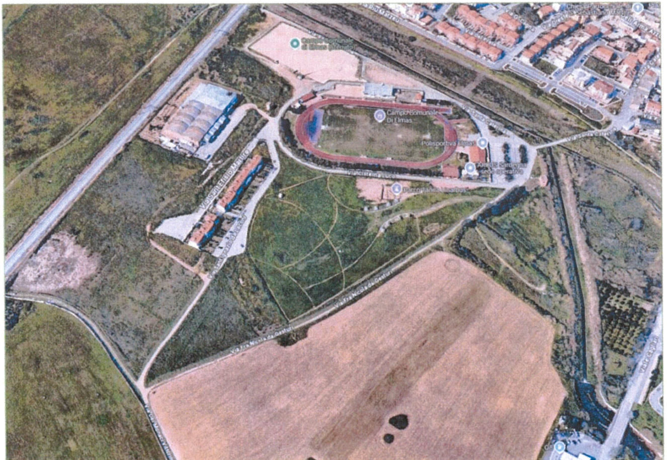
Foto n° 4: Vista aerea 3d della zona (fonte Google Earth – immagine anno 2024)
