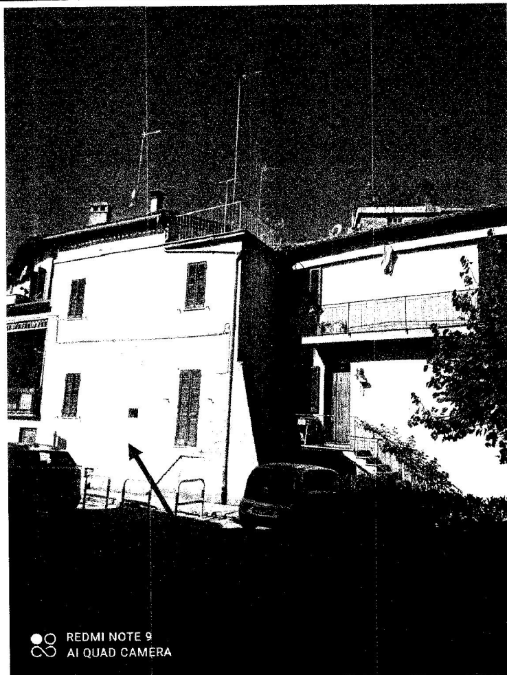
Foto n. 2 – Vista d’insieme ravvicinata del prospetto principale lungo Via Roma
