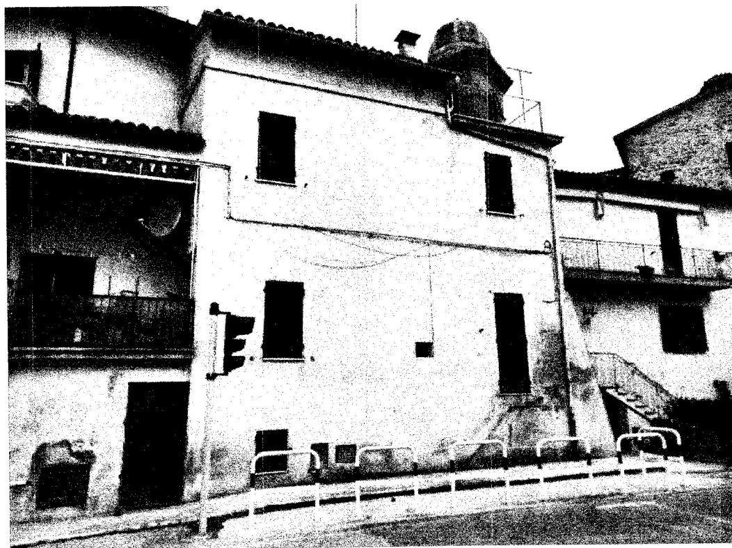
Foto n. 3 – Vista particolare del prospetto principale lungo Via Roma
