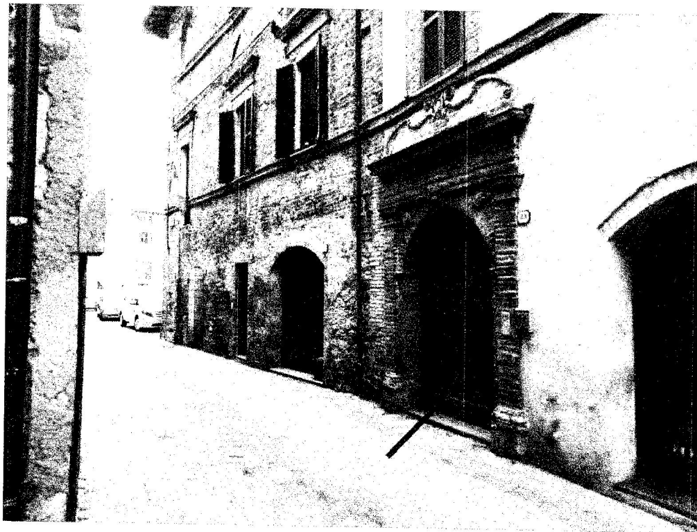
Foto n. 5 – Vista ingresso lungo Via Amedeo di Savoia (freccia rossa)
