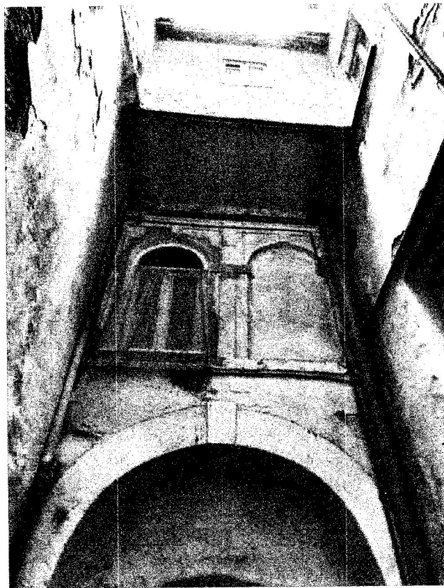
Foto n. 11 – Vista dalla corte interna del prospetto interno ove sono visibili i vani destinati ad angolo cottura (piano primo vano n. 8) e wc (piano secondo vano n.12 nelle planimetrie rilevate – allegato 3)
