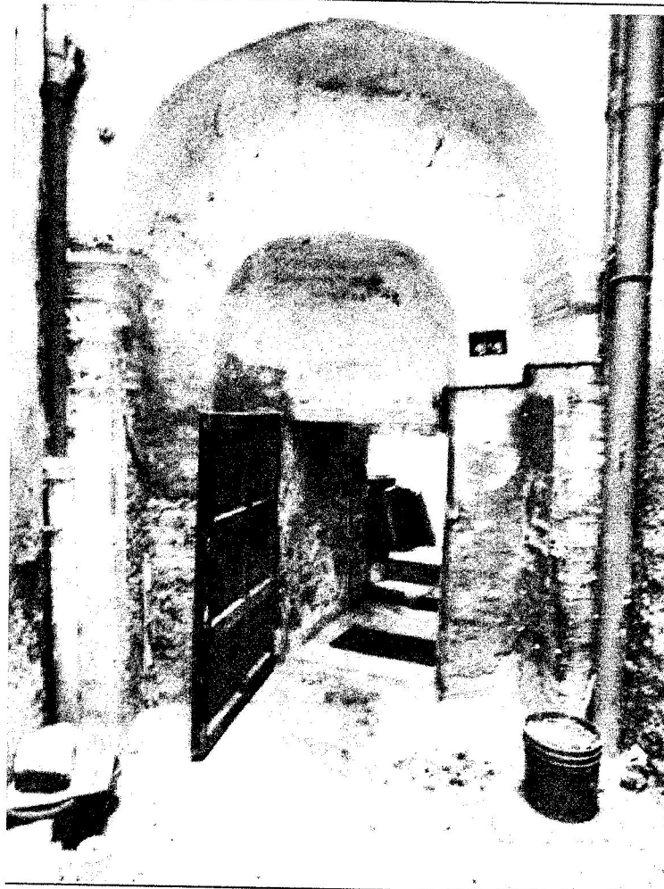
Foto n. 12 – Vista accesso al fondo (vano n. 4 nelle planimetrie rilevate – allegato 3)
