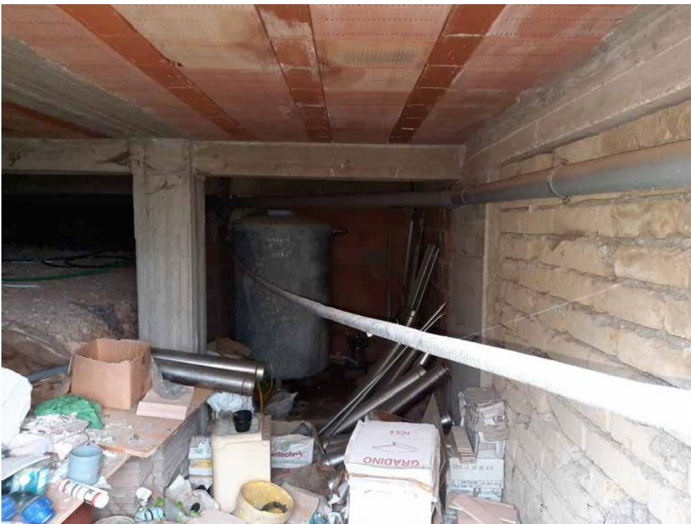
Foto 24: Abitazione B (foglio 27 particella 806 sub 2) – deposito piano 2/S
