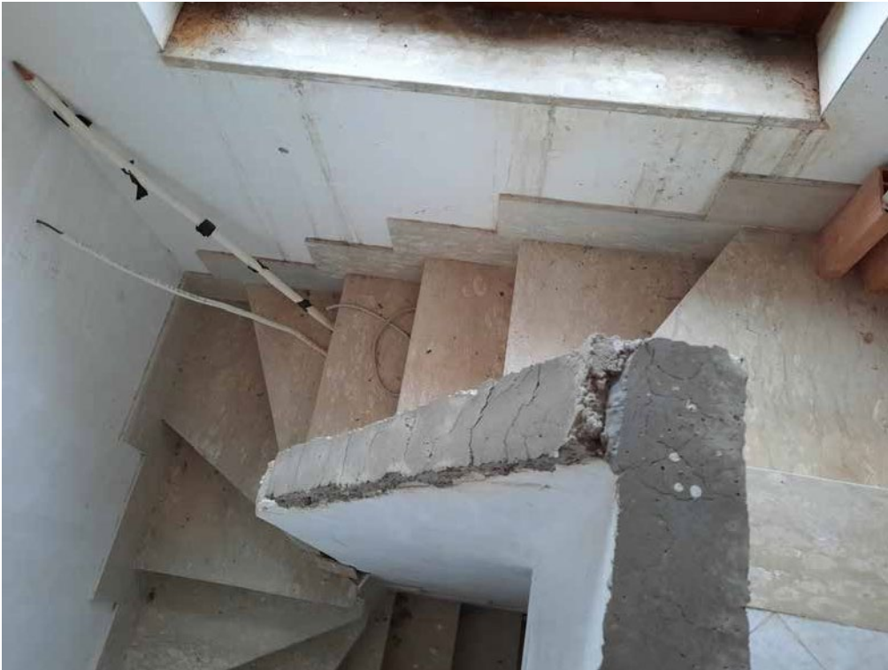
Foto 39: Abitazione B (foglio 27 particella 806 sub 2) scala piano sottotetto
