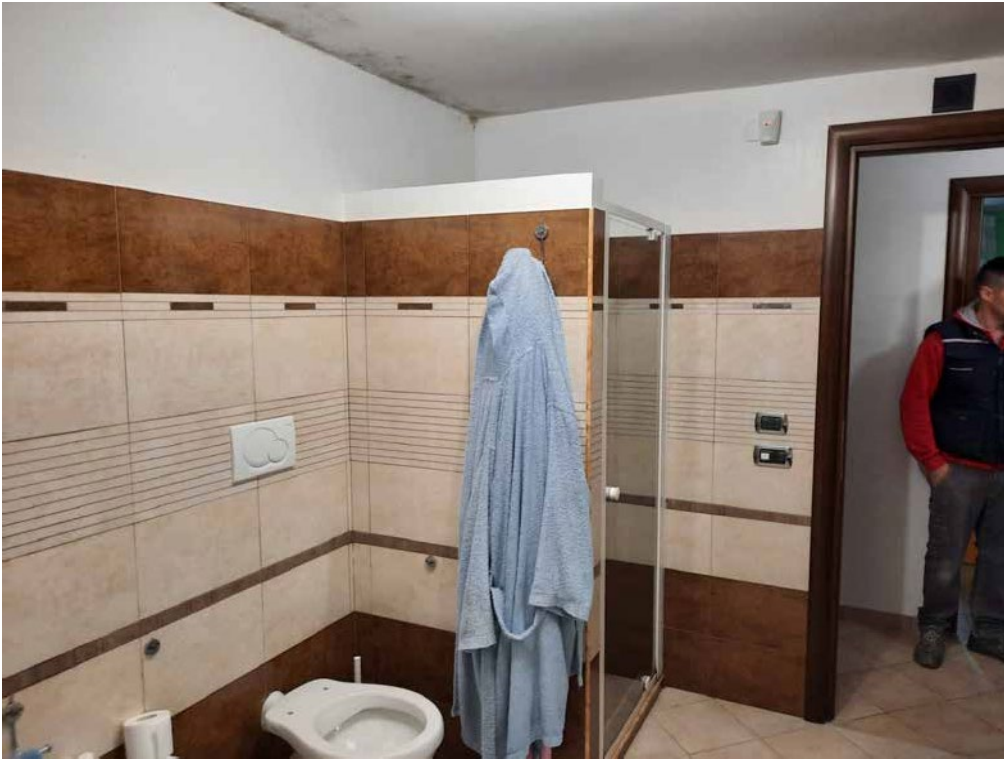
Foto 65: Abitazione D (foglio 27 particella 806 sub 3) – bagno piano 2/S
