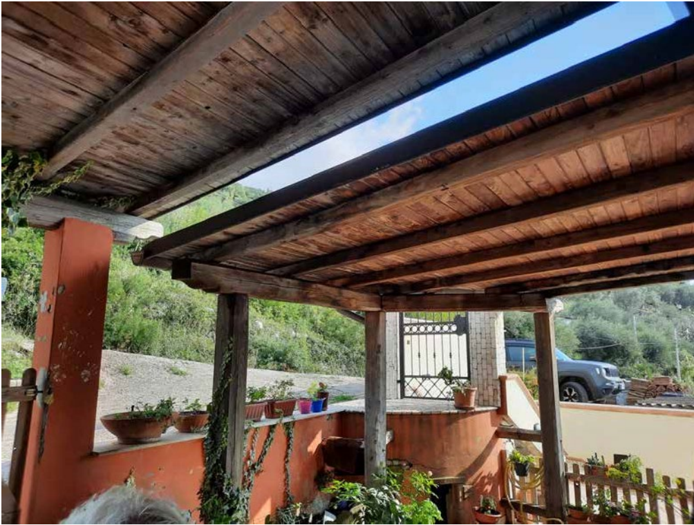
Foto 7: Tettoie abitazione A (foglio 27 particella 806 sub 1)
