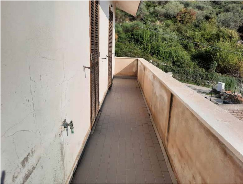
Foto 19: Abitazione A (foglio 27 particella 806 sub 1) – balcone (P1)
