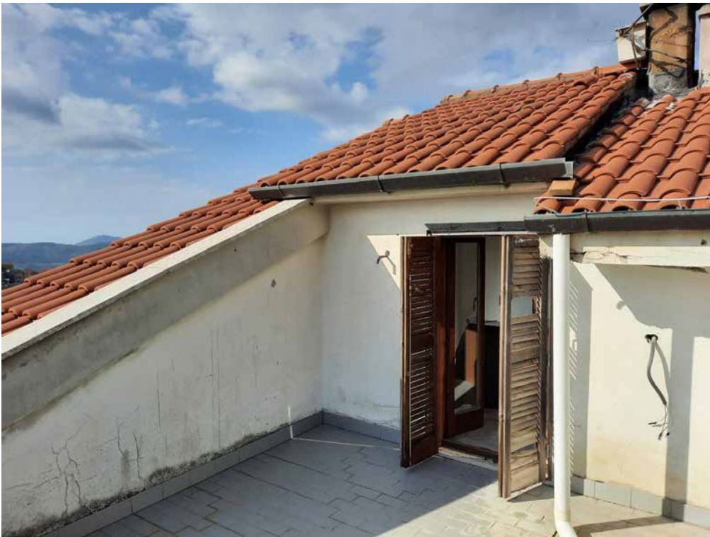
Foto 22: Abitazione A (foglio 27 particella 806 sub 1) – terrazzo piano sottotetto
