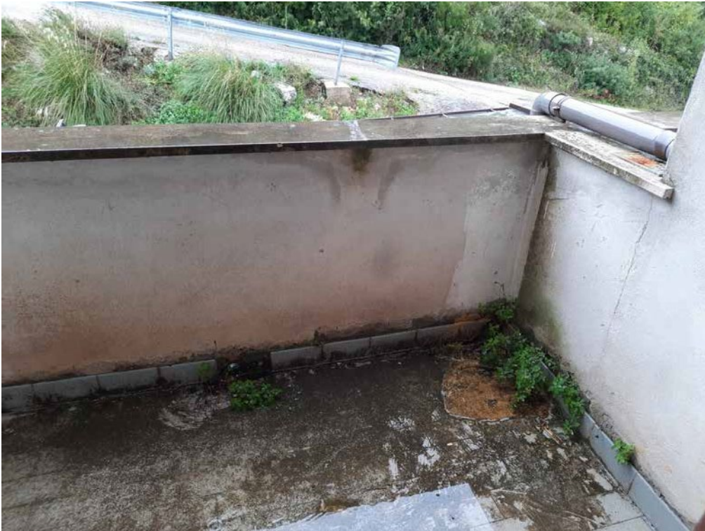
Foto 37: Abitazione B (foglio 27 particella 806 sub 2) – balcone 2 P1
