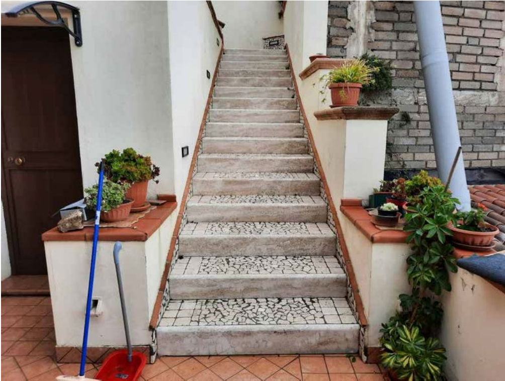
Foto 53: Abitazione D (foglio 27 particella 806 sub 1) – scala esterna di accesso 1/S
