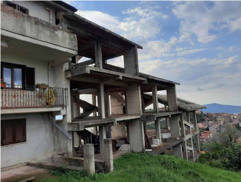
Foto 71: porzione fabbricato non completato lato ovest
