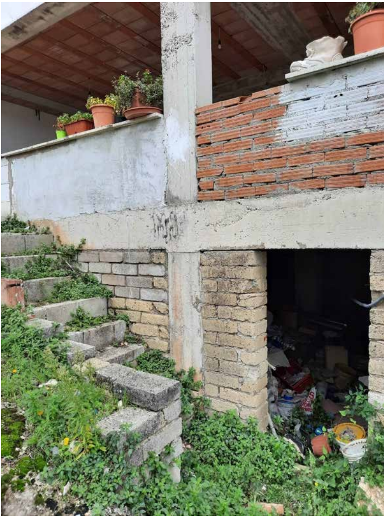
Foto 23: Abitaz. B – deposito piano 2/S
