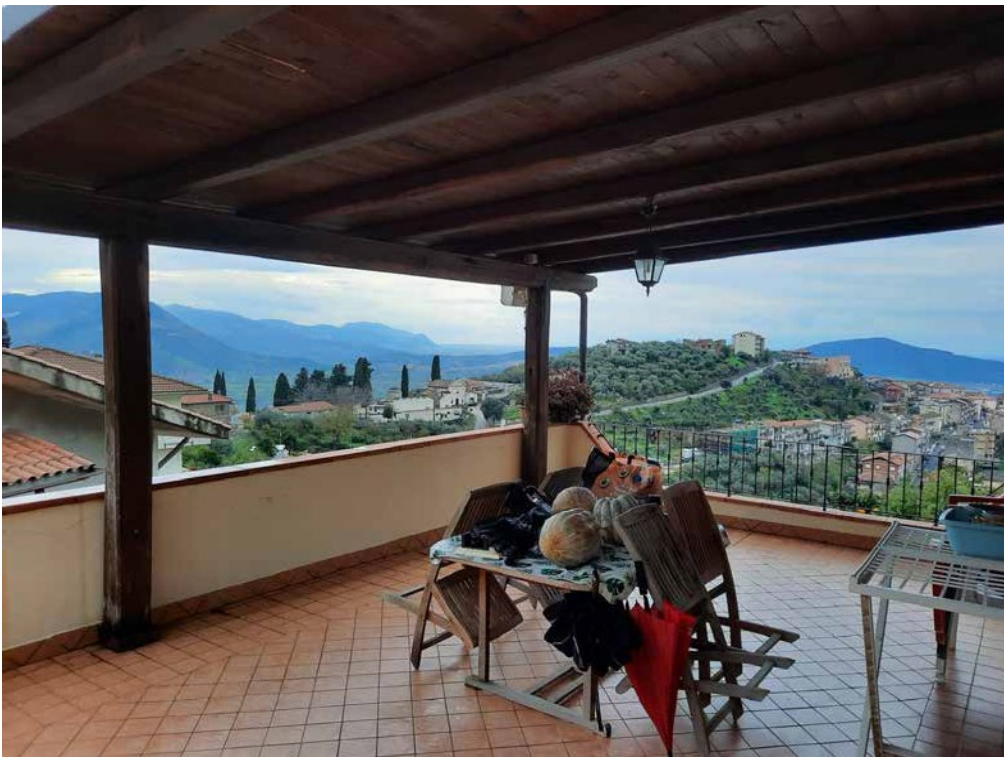
Foto 54: Abitazione D (foglio 27 particella 806 sub 1) – terrazzo-tettoia 1/S
