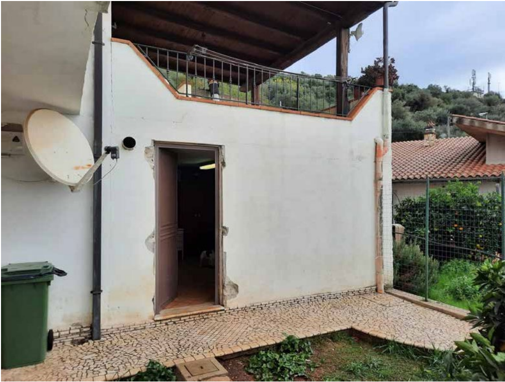
Foto 69: Abitazione D (foglio 27 particella 806 sub 3) – giardino e deposito piano 2/S
