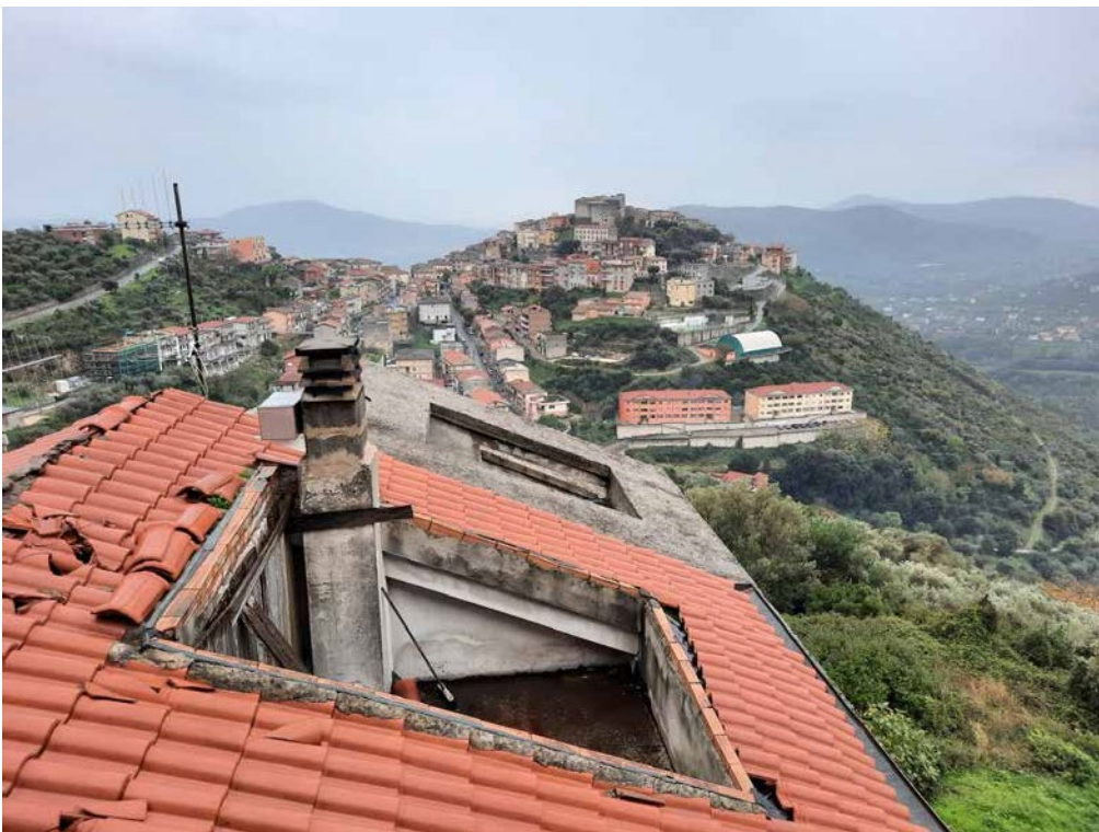
Foto 52: Abitazione C (foglio 27 particella 806 sub 3) – copertura a tetto
