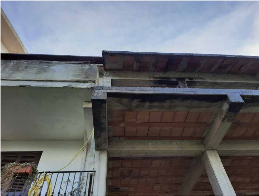
Foto 73: porzione fabbricato non completato attacco con porzione terminata
