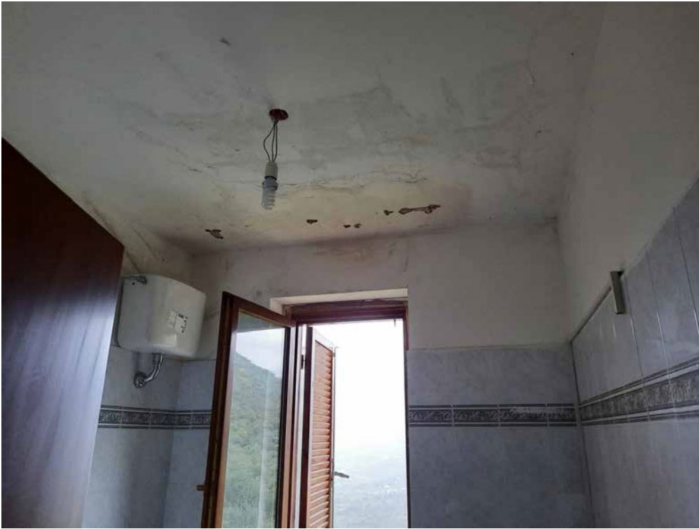
Foto 31: Abitazione B (foglio 27 particella 806 sub 2) – bagno P1
