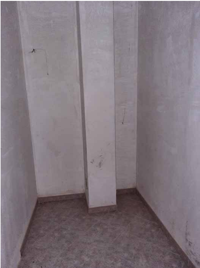
Foto 36: Abitaz. B – disimpegno P1
