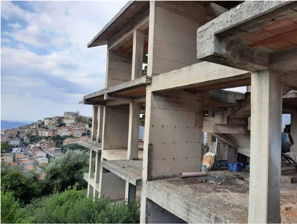
Foto 75: porzione fabbricato non completato lato est
