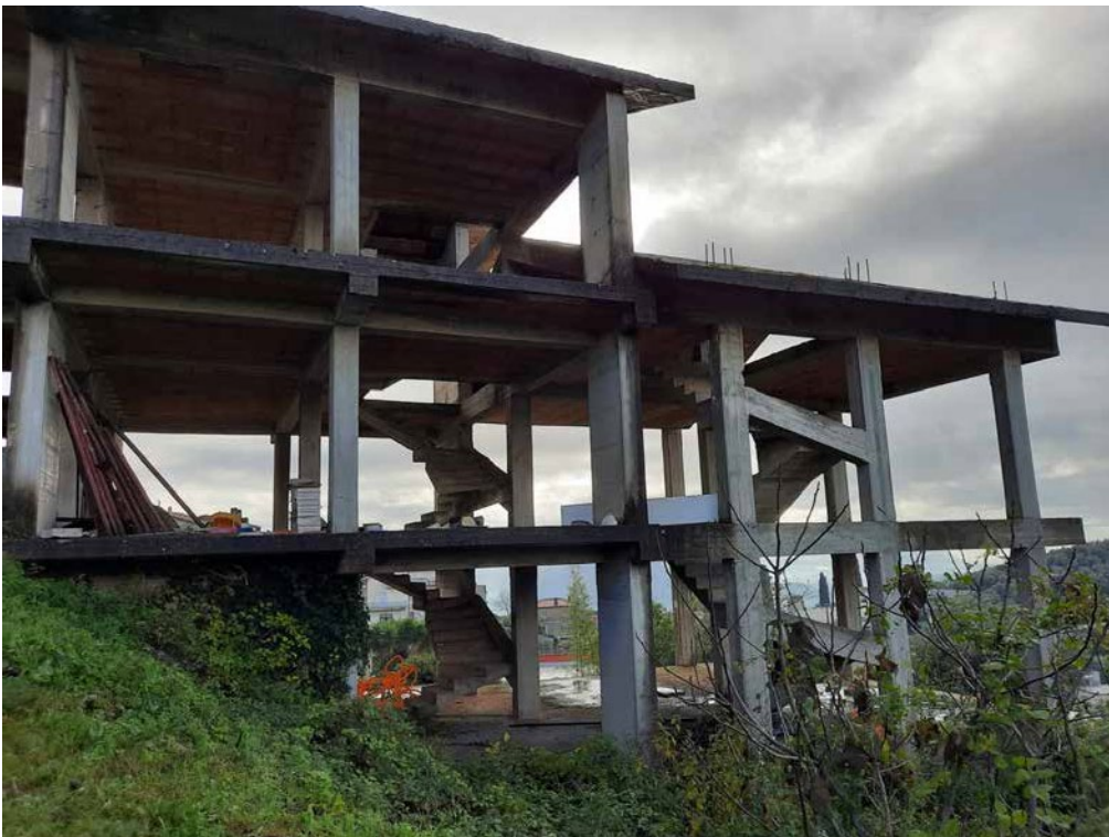
Foto 72: porzione fabbricato non completato lato ovest
