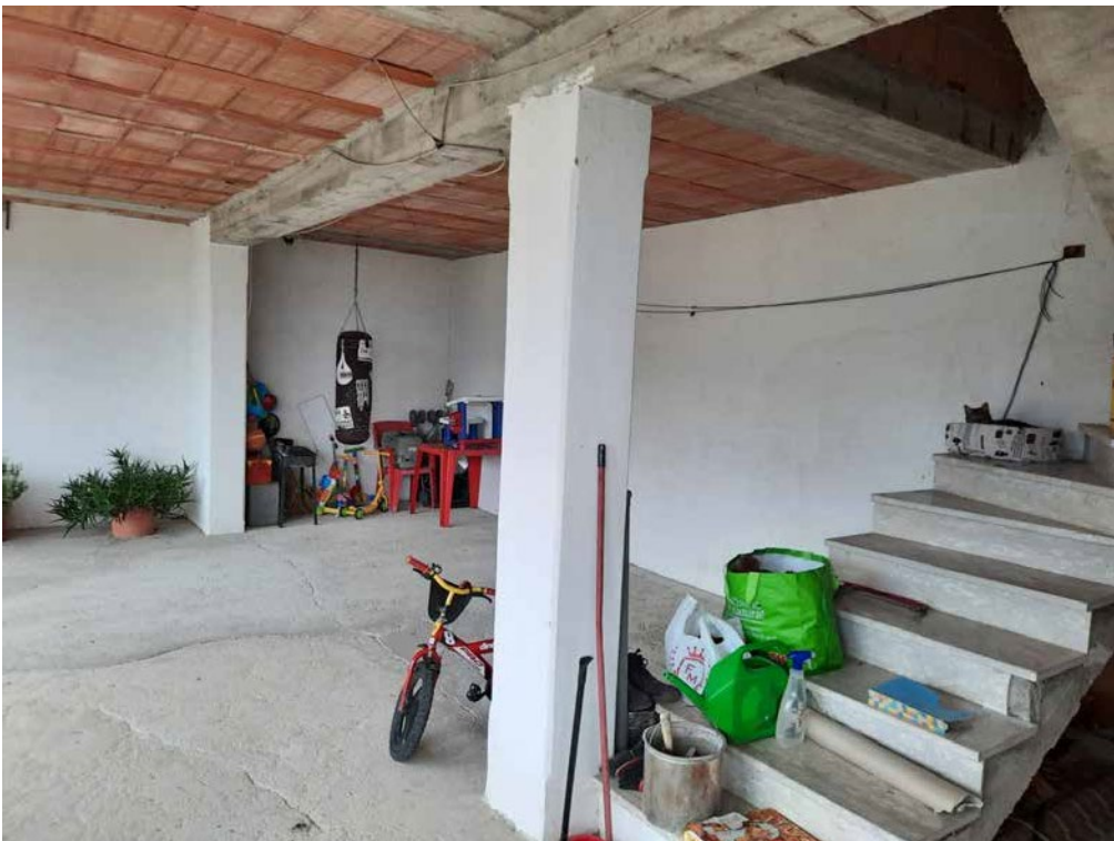
Foto 26: Abitazione B (foglio 27 particella 806 sub 2) – ‘portico’ piano 1/S
