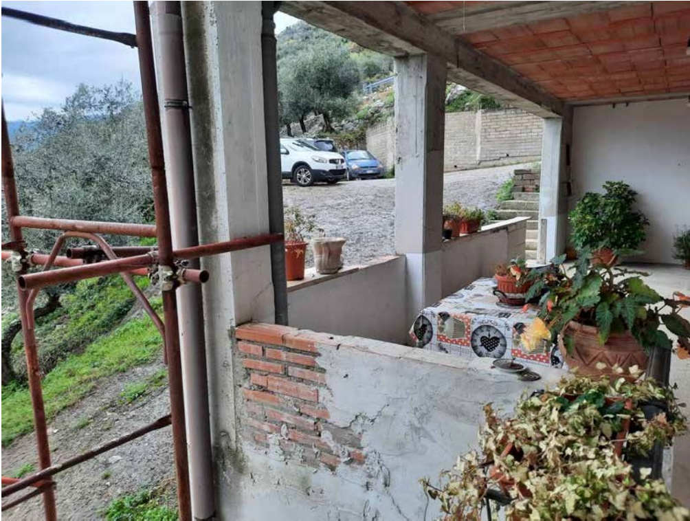
Foto 25: Abitazione B (foglio 27 particella 806 sub 2) – ‘portico’ piano 1/S
