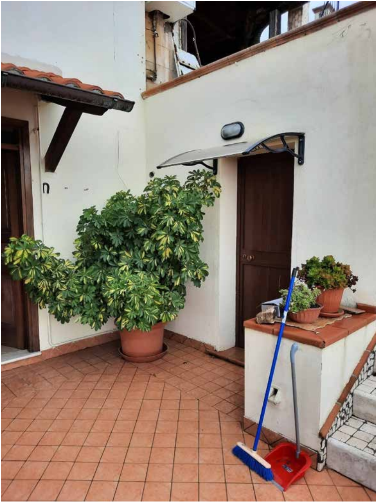
Foto 55: Abitazione D (foglio 27 particella 806 sub 1) – terrazzo-tettoia 1/S
