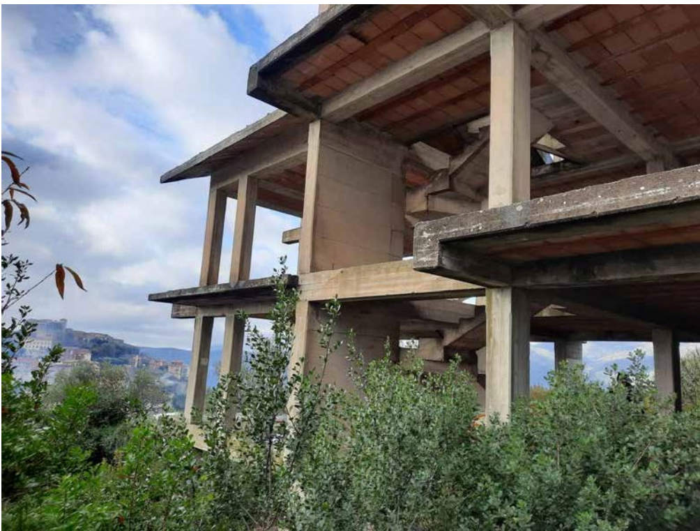
Foto 76: porzione fabbricato non completato lato est
