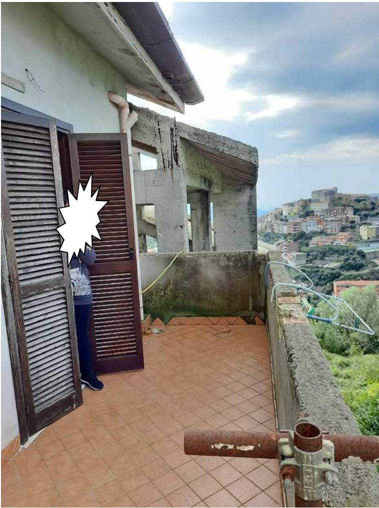
Foto 51: Abitaz. C – balcone 1 PT
