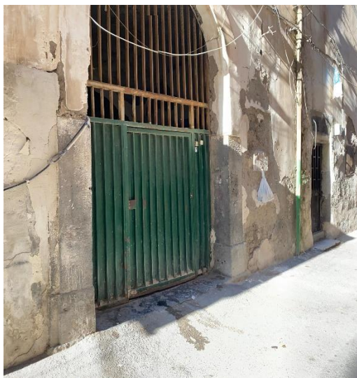
Figura 5- portone di ingresso
