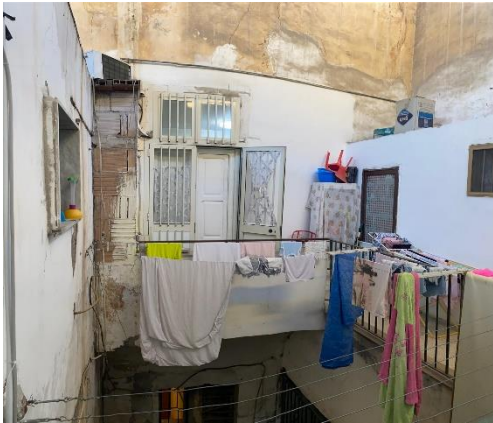
Figura 42- porta di accesso all'unità immobiliare
