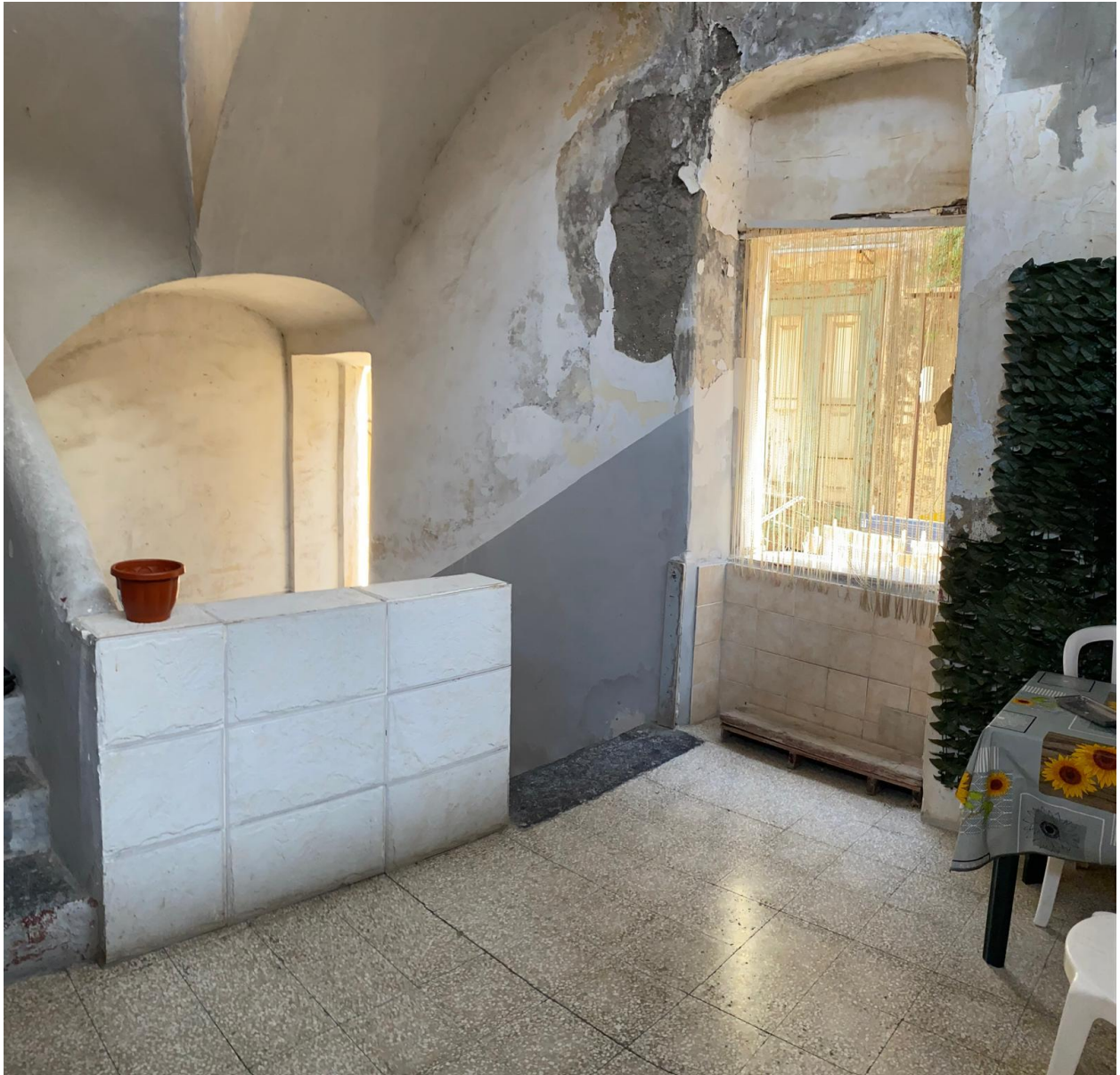
Figura 52- pianerottolo del primo piano
