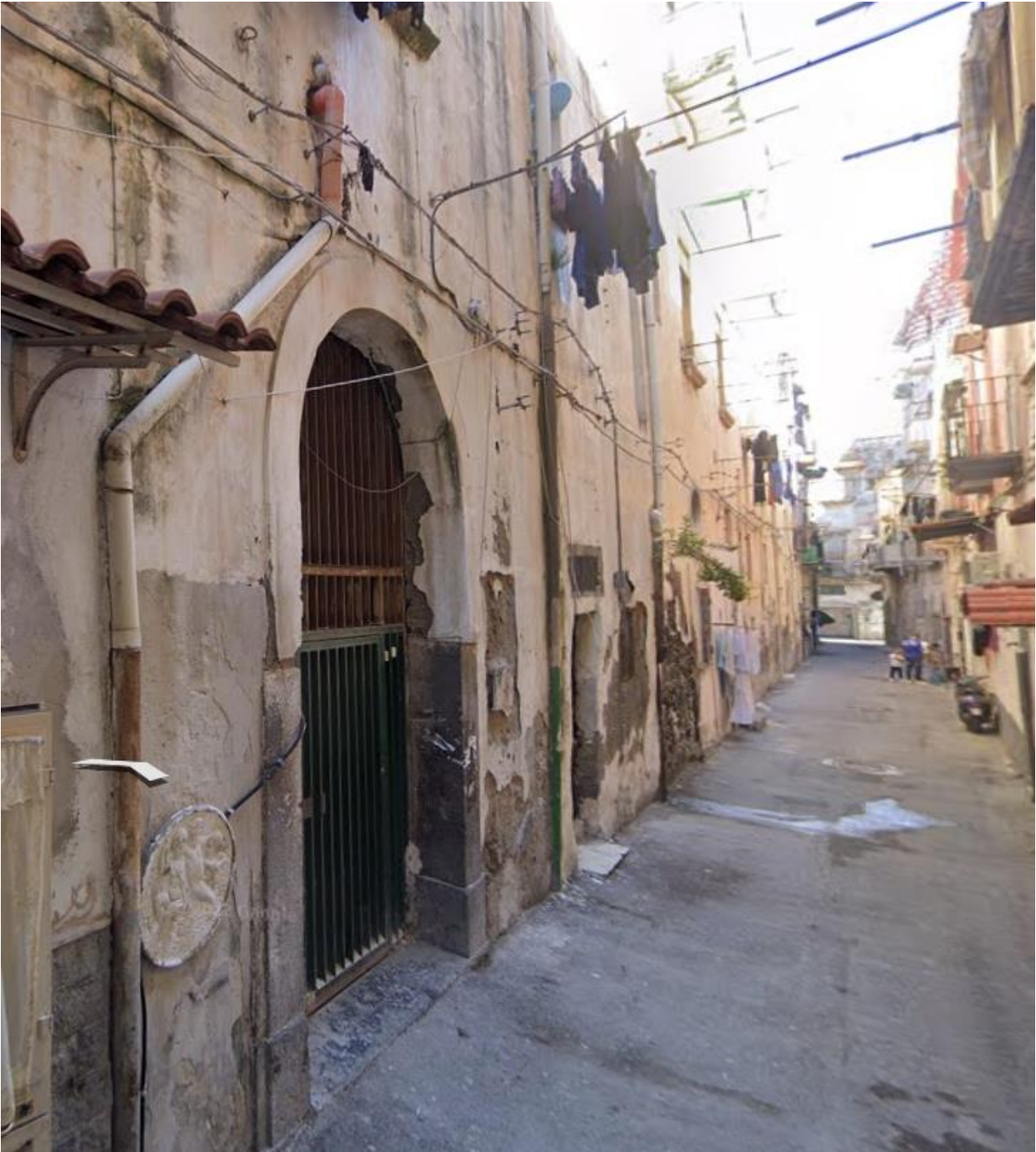
Figura 49- Via Rosselli – Portone di accesso al fabbricato
