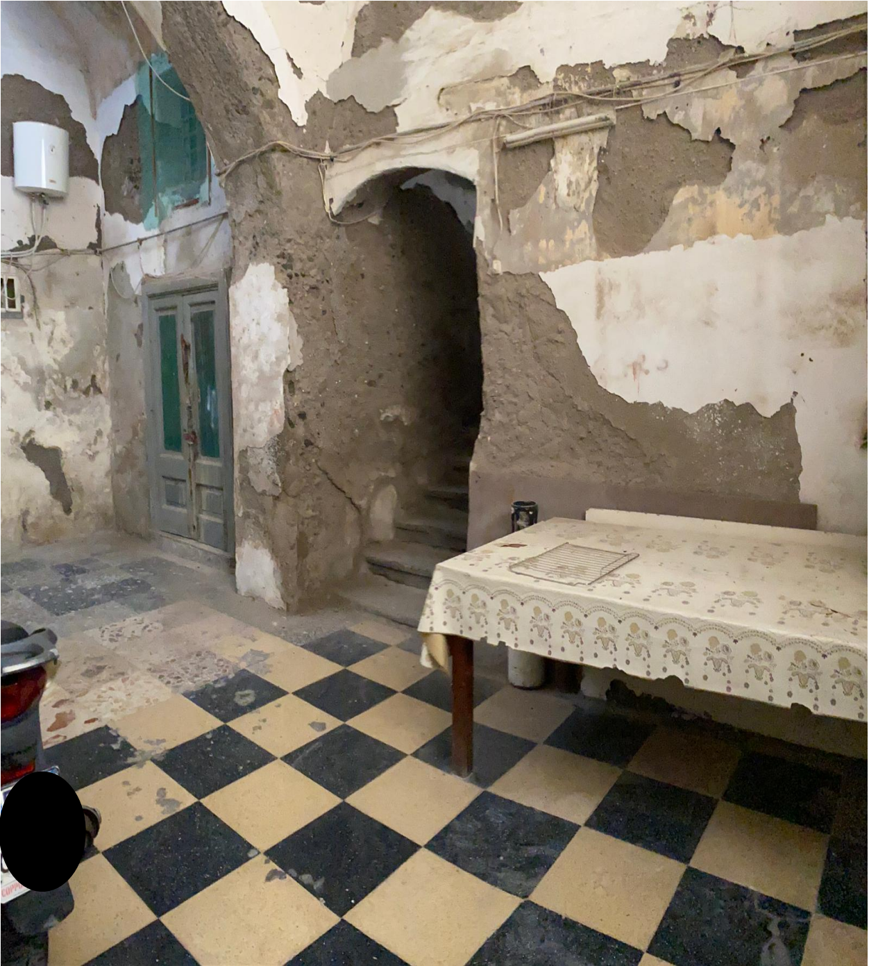
Figura 50- corte interna- accesso al vano scala
