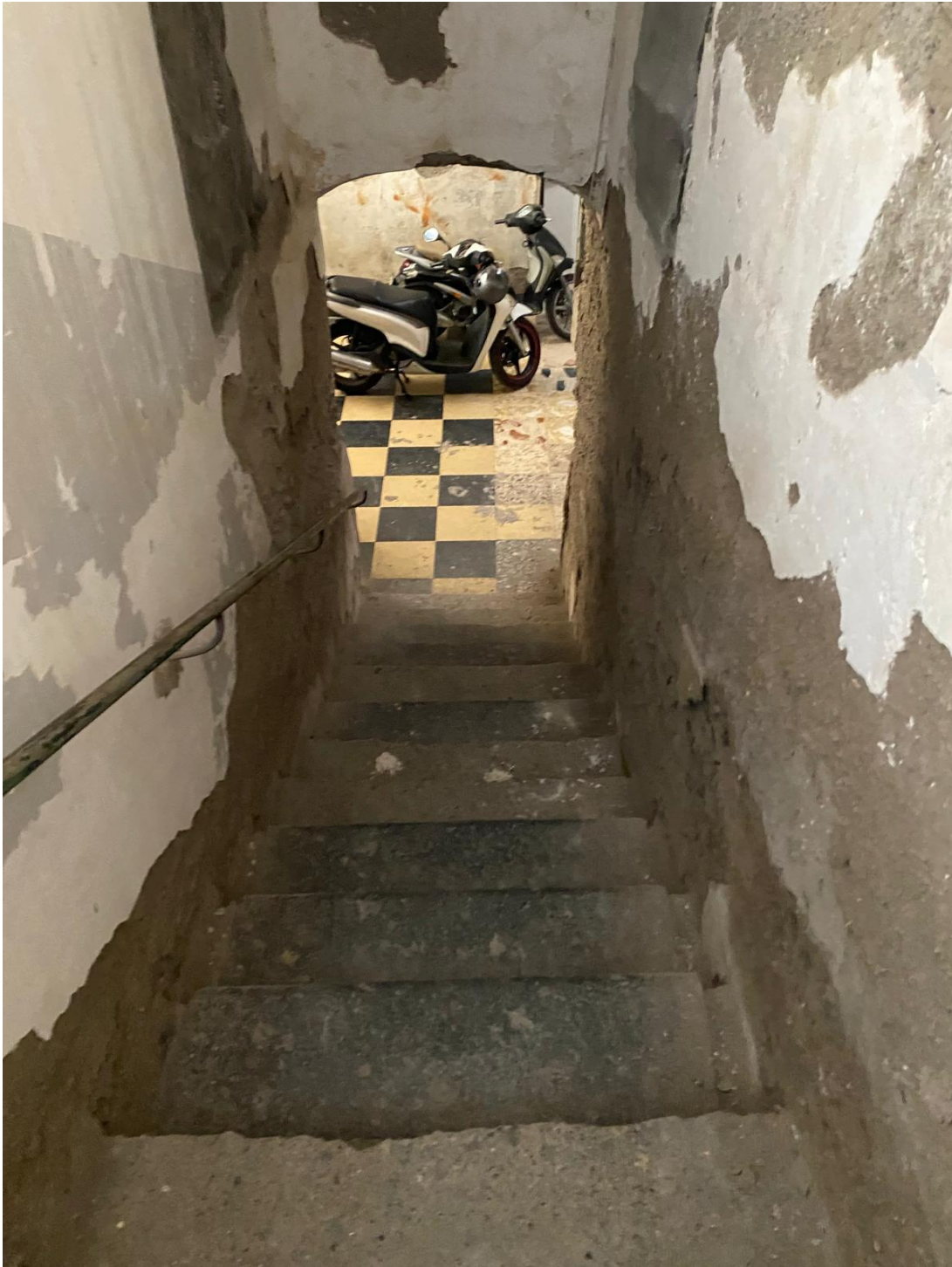
Figura 51- rampa di scala
