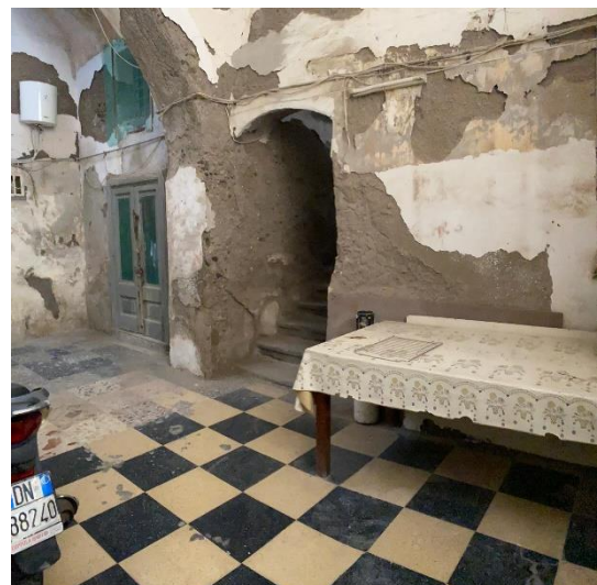
Figura 6- rampa di accesso
