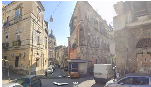
Figura 3- Vista su Via Carducci
