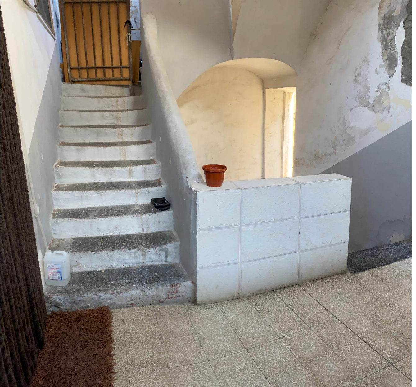
Figura 53- rampa di scale che conduce al lastrico solare
