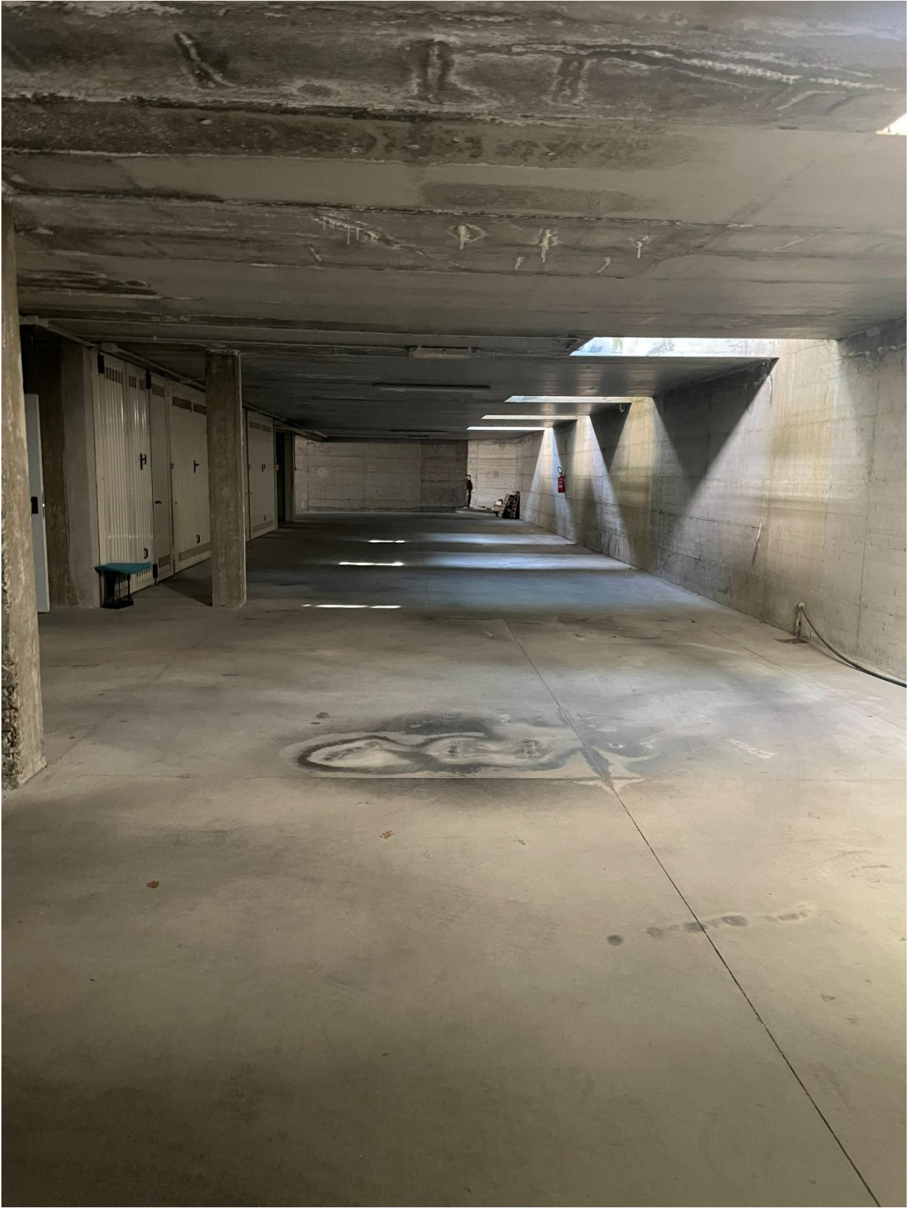
AREA DI MANOVRA PIANO INTERRATO
