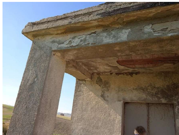
Part. 811 sub 2 - Vista interna
