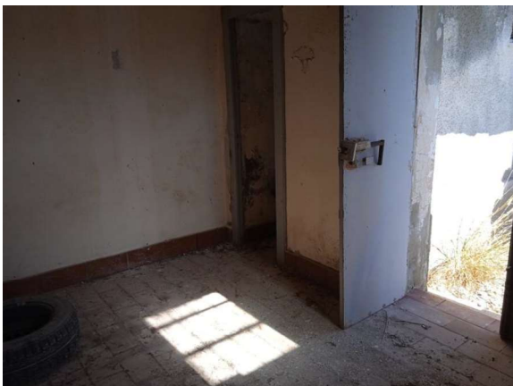
Part. 811 sub 2 - Vista interna
